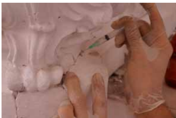
FIG. 4. Inyección de adhesivo (Augustin, R. 2014).
