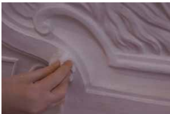
FIG. 1. Limpieza en húmedo (Almada, A. 2014).
