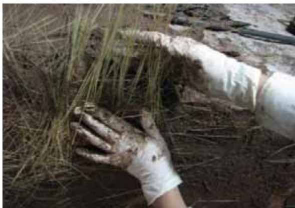
FIG. 4. Detalle de embarre o enfoscado en las zonas faltantes (Martínez F. 2010)
