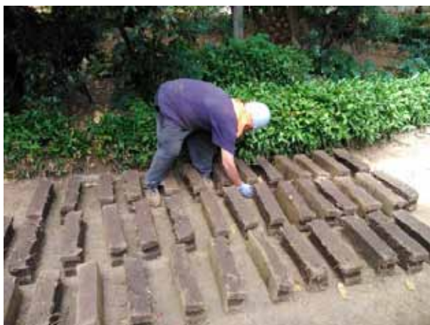
FIG. 6. Proceso de fabricación de adobe en Palacio Rioja.
