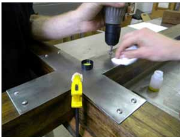
FIG. 5. Refuerzo metálico en la crucería. (Archivo CNCR, Soffia, 2011)
