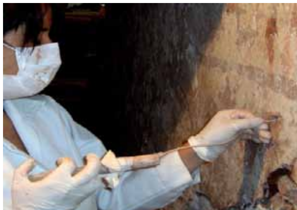
FIG. 3. Aplicación del mortero de inyección (Martínez F. 2009)
