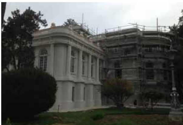
FIG. 10. Proceso de restauración de la fachada del Palacio Rioja.
