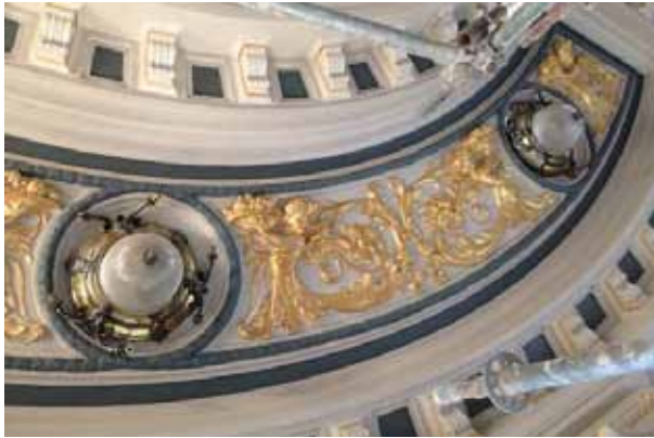
FIG. 8. Restauración del cielo en Salón Comedor del Palacio Rioja.
