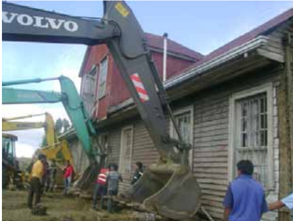
FIG. 5. Maquinaria unida a las yugeras para tiradura controlada y homogénea (I. Municipalidad de Chonchi, 2009)
