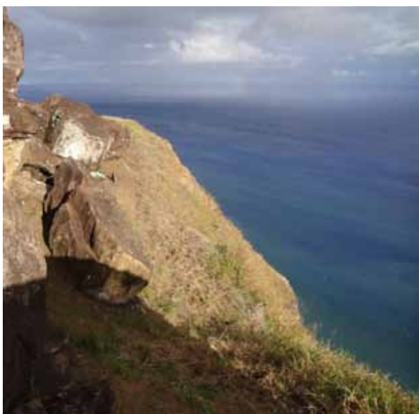
FIG.2. Bloque en peligro de caída (Castellar, N. 2013)
