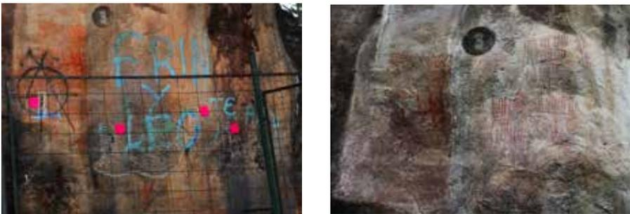
**Figura 56.** Piedra No. 3 antes (izquierda) y después de la limpieza mediante microabrasímetro (derecha).
