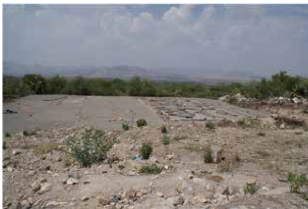
Figura 3. Vista de los daños causados a la terraza 1 cuando se pensó construir una estación de bombeo. Foto: Marco Alejandro Sánchez Velázquez
