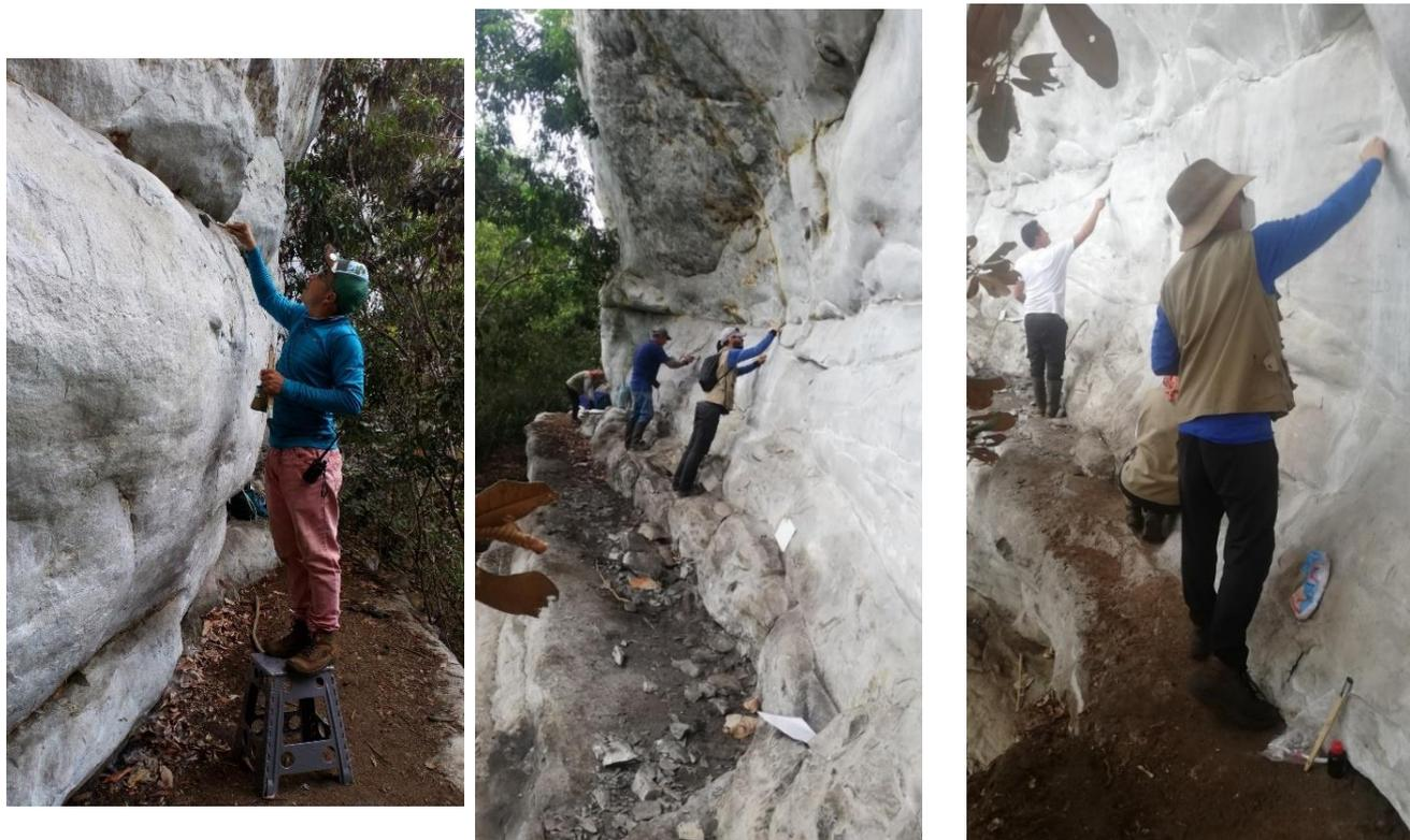
**Ilustración 120.** Limpieza superficial de la roca con brochas y cepillos para eliminación material agregado (tierra, telarañas, etc.) y borrado de grafitis.
