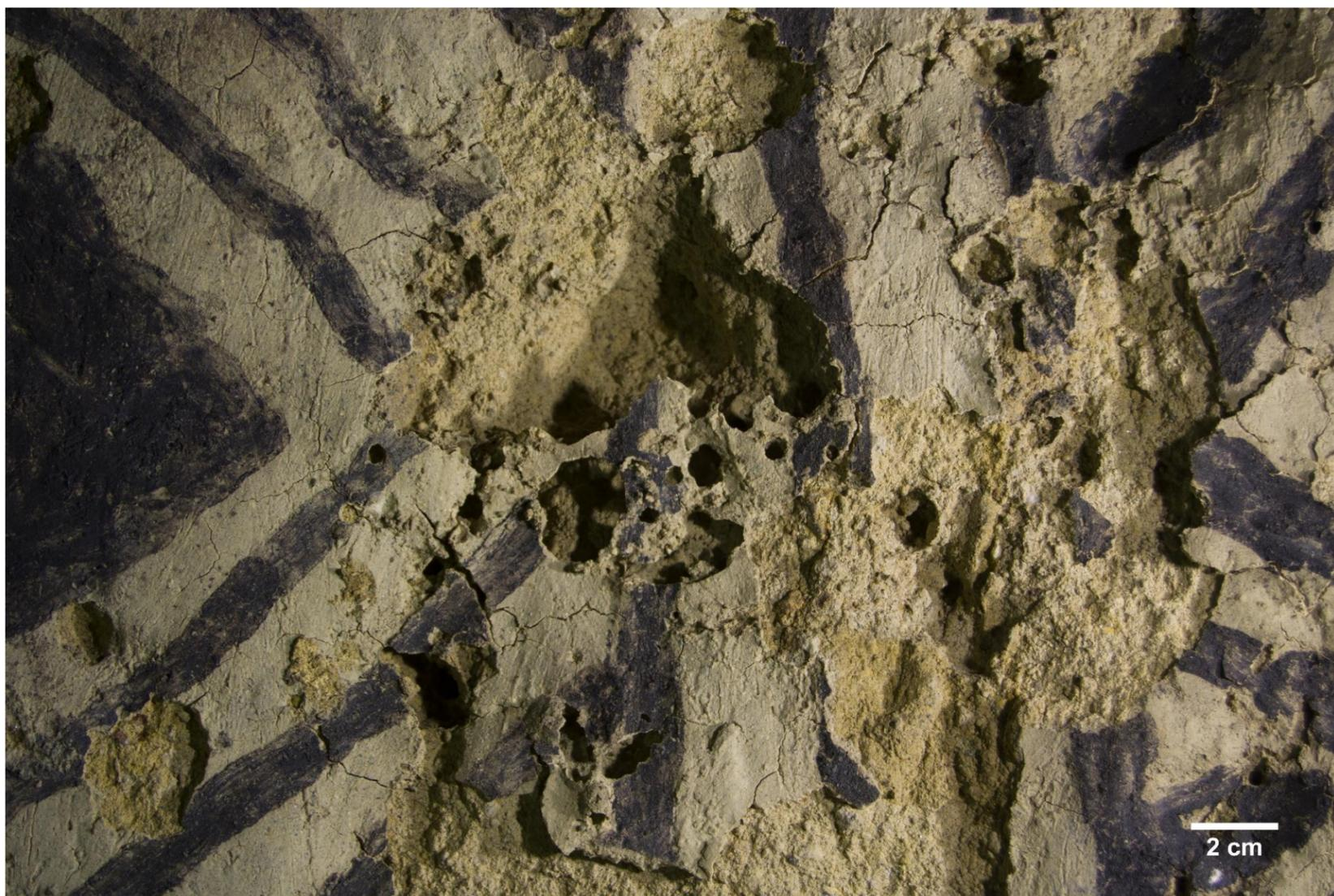
*Desprendimiento del enlucido debido a cavidades excavadas por miriápodos y coleópteros. Se nota también el resecamiento del enlucido causando fisuras y craqueladuras.*
