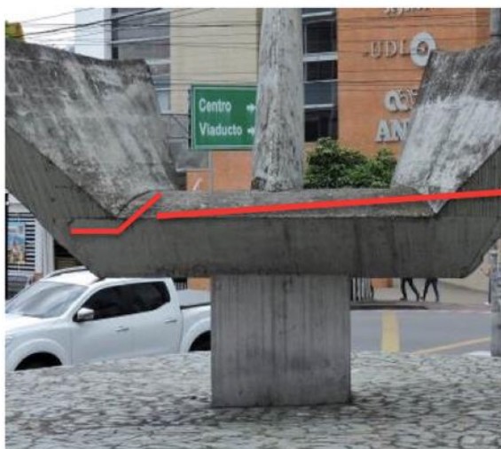
Fotografía 11. Reverso. Junto a las líneas rojas se pueden ver las dilataciones testigo de la fundición de los elementos que conforman la estructura.
