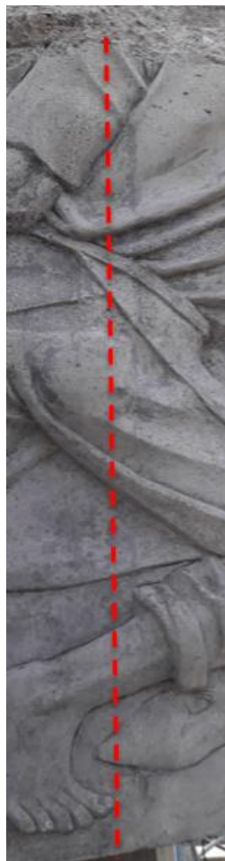
Fotografía 20 y 21. A la derecha de la línea punteada se aprecia una línea recta correspondiente a la huella de dos de los moldes empleados en la fundición de las imágenes del relieve.
