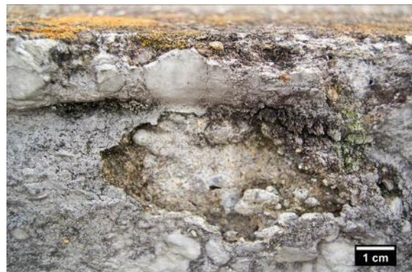
Fotografía 83 y detalle. Detalles de zonas donde se evidencia el nivel avanzado de deterioro a causa de la falta de cohesión de las partículas de mortero.
