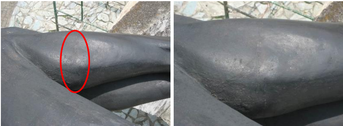
Fotografía 30 y detalle. Vista general de la zona de soldadura a la altura de la pantorrilla
