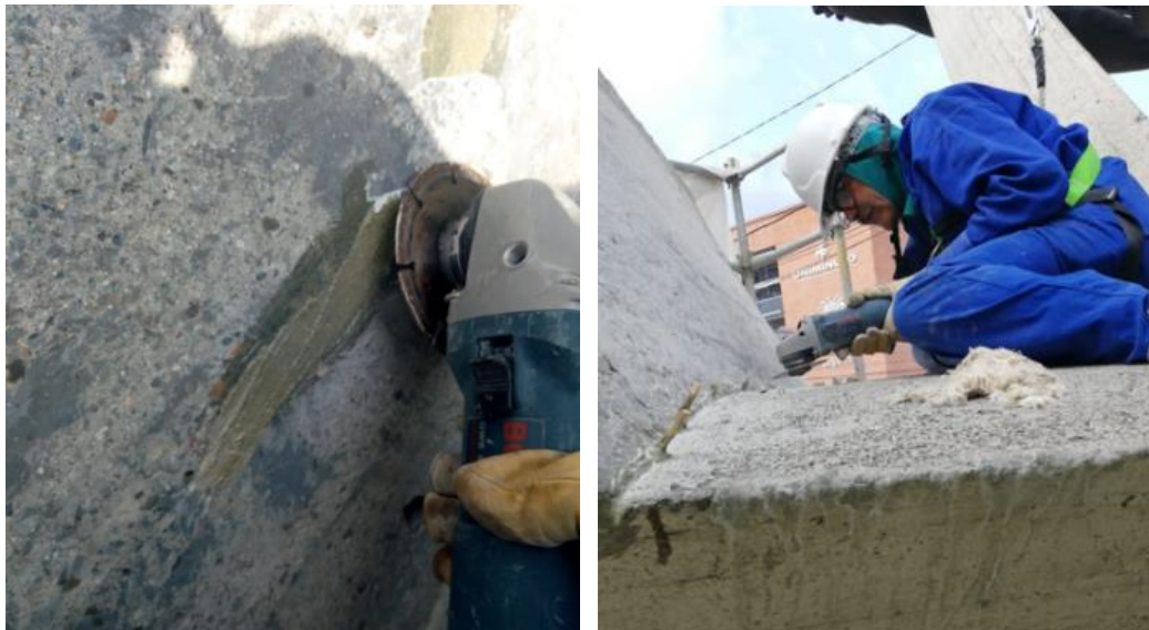
Fotografía 447 y 138. Eliminación de material sellante en zona de inyección de fisuras
