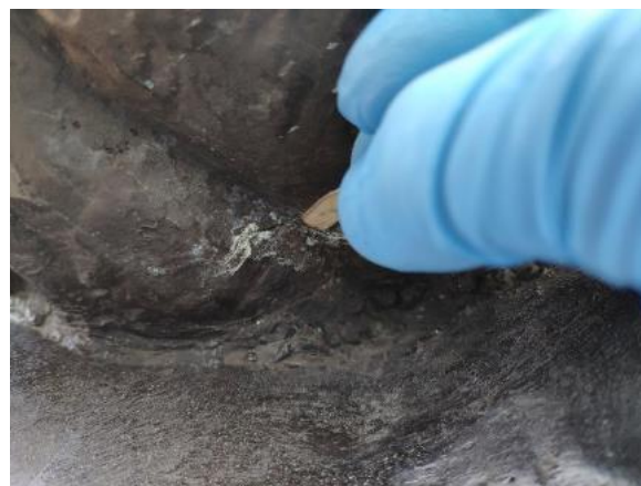
Fotografía 118 y 119. Proceso de eliminación de productos de corrosión
