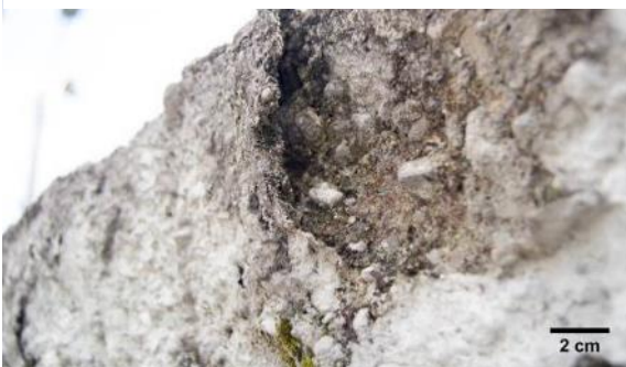
Fotografía 84 y detalle. Nivel avanzado de deterioro a causa de la falta de cohesión de las partículas de mortero
