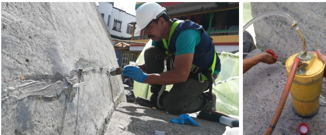
Fotografía 135. Sellado e instalación de conductos de inyección de fisuras, 136. Resina fluyendo para la inyección de fisuras
