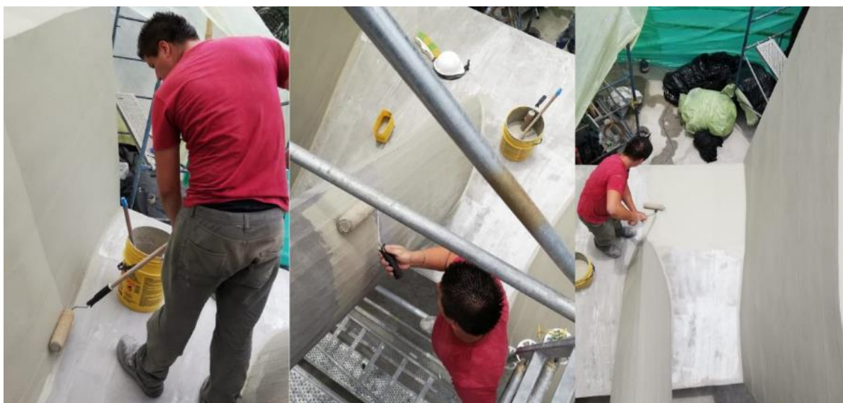
Fotografía 188 a 190. Aplicación de la capa de pintura sobre la estructura de concreto
