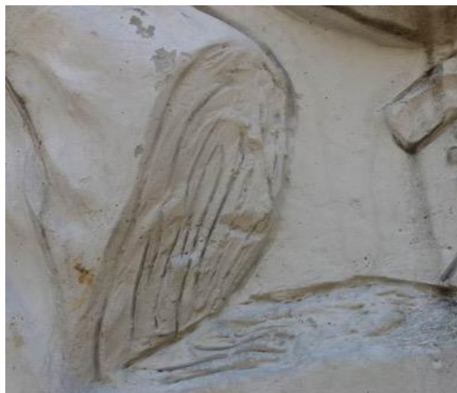
Fotografía 14. Formas donde la incisión fue un recurso escultórico para dar fuerza a las formas. Esta incisión tuvo que hacerse una vez se retiraron las formaletas y se estaban dando los retoques a las formas del relieve.
