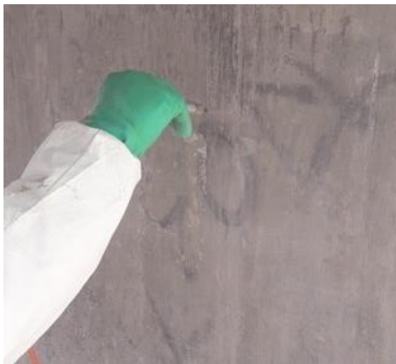
Fotografía 132. Eliminación con microabrasímetro de grafitis que aparecieron bajo capas de pintura
