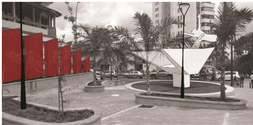
Ilustración 14. Muro artístico como planos de cerramiento del espacio
