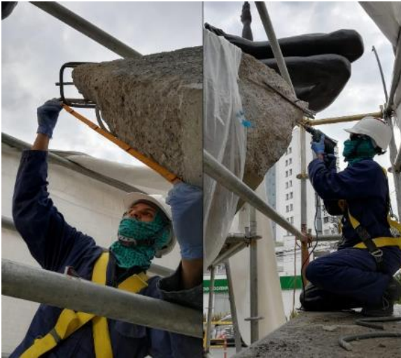
Fotografía 143 a 145. Instalación de puntos de anclaje que soportarán el concreto fundido en formaleta
