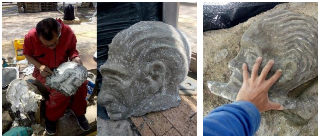
Fotografía 168 a 170. Desmolde de la figura, eliminación de excesos de yeso y ubicación de la figura sobre el ST122 aplicado a la la superficie del trapecio occidental.
