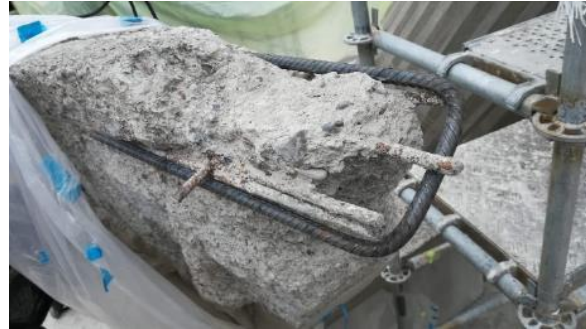
Fotografía 143 a 145. Instalación de puntos de anclaje que soportarán el concreto fundido en formaleta
