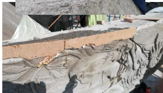
Fotografía 149 y 150. Instalación de formaletas y aplicación de Sika concrelisto RE-5000
