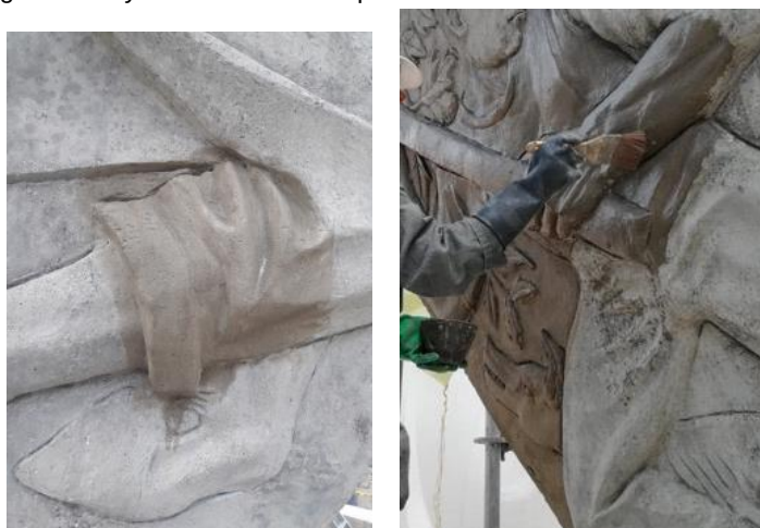
Fotografía 186 y 187. Proceso de aplicación de mortero en relieves
