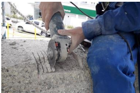
Fotografías 147 y 148. Retiro de material para corrección de pendiente en los bordes superiores de los trapecios
