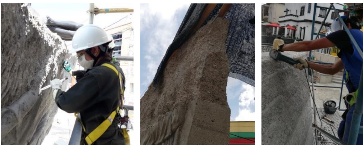
Fotografía 140 a 142. Eliminación de concreto muy alterado en la parte superior de los aleros
