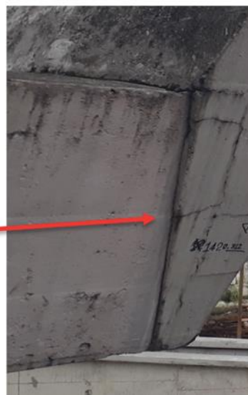
Fotografía 11. Reverso. Junto a las líneas rojas se pueden ver las dilataciones testigo de la fundición de los elementos que conforman la estructura.
