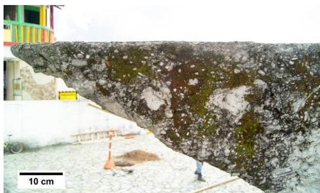
Fotografía 72. Acercamiento a zonas que presentan diferentes tipos de crecimiento biológico
