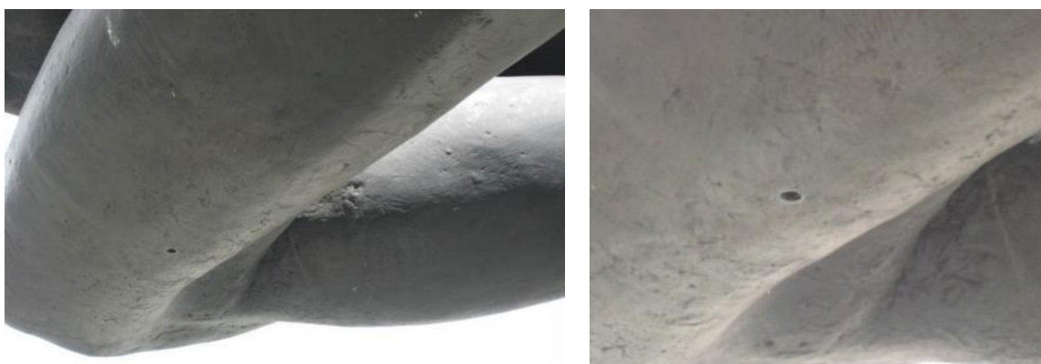
Fotografía 28 y detalle. Orificio en la pierna izquierda de la figura, es posible que corresponda a uno de los bebederos
