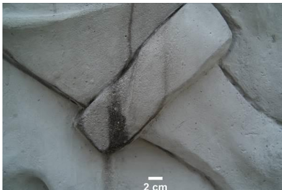
Fotografía 80 y detalle. Acercamiento a zonas erosionadas donde se pueden ver elementos que componen la estructura del mortero y pérdida de acabado de superficie.
