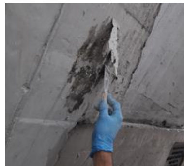
Fotografía 126. Hidrolavado que permite eliminación parcial de repintes
