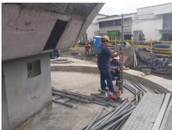
Fotografía 43 y 105. Instalación de andamios y cerramiento
