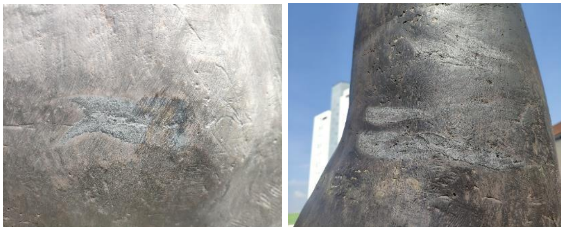
Fotografías 114 y 115. Proceso de eliminación de las intervenciones anteriores en mal estado
