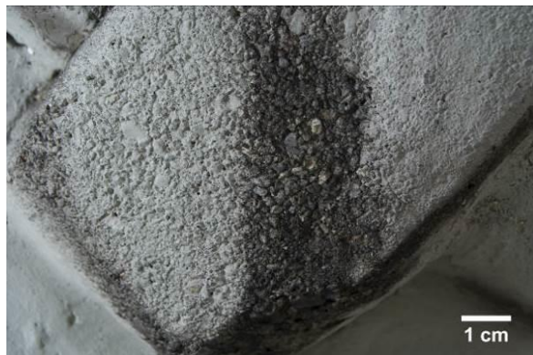
Fotografía 80 y detalle. Acercamiento a zonas erosionadas donde se pueden ver elementos que componen la estructura del mortero y pérdida de acabado de superficie.
