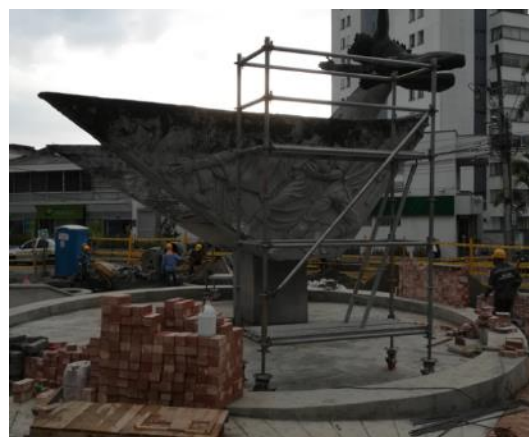
Fotografía 43 y 105. Instalación de andamios y cerramiento
