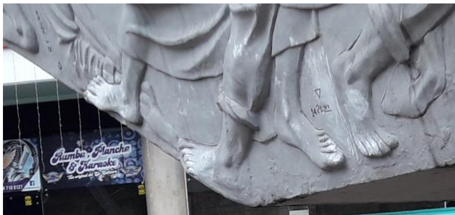
Fotografía 34. Manchas de pintura blanca en la zona inferior del relieve occidental
