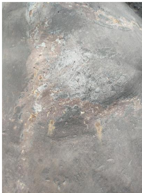
Fotografía 116 y 117. Intervenciones anteriores, recubrimientos puntuales de cera
