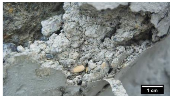
Fotografía 84 y detalle. Nivel avanzado de deterioro a causa de la falta de cohesión de las partículas de mortero
