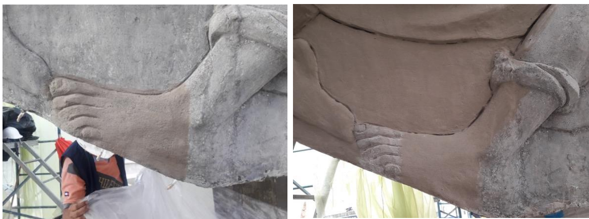
Fotografía 184 y 185. Proceso de aplicación de mortero en relieves
