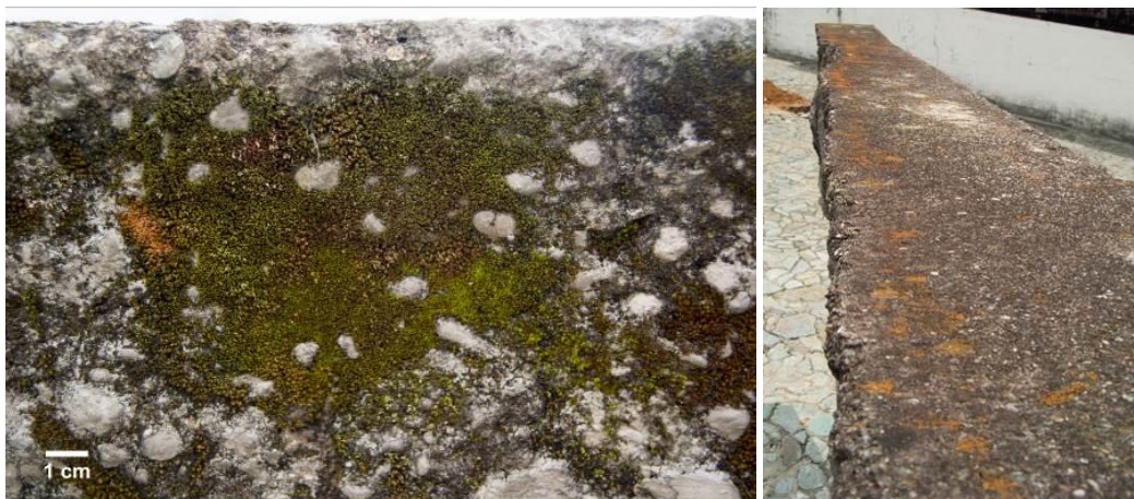
Fotografía 3 y 74 Acercamiento a zonas que presentan diferentes tipos de crecimiento biológico
