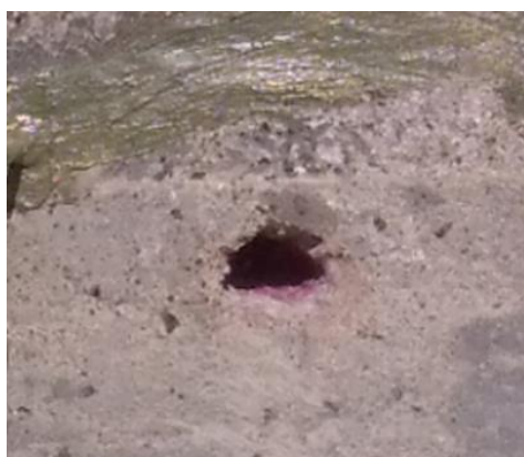
Fotografía 139. Perforación del trapecio oriental donde se aplicó la prueba con fenolftaleína.
