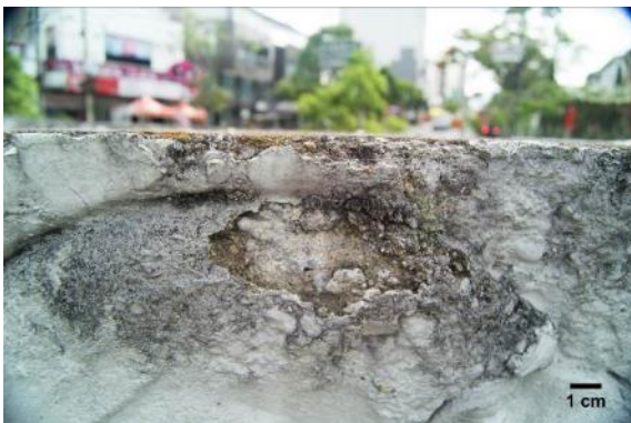
Fotografía 83 y detalle. Detalles de zonas donde se evidencia el nivel avanzado de deterioro a causa de la falta de cohesión de las partículas de mortero.
