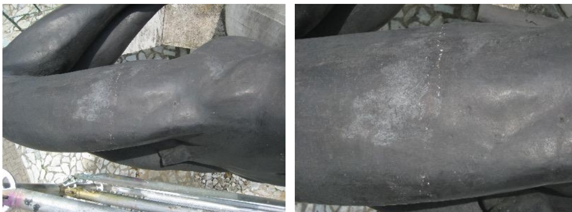
Fotografía 15 y detalle. Vista general de zona de soldadura a la altura del muslo
