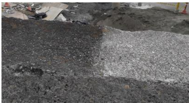
Fotografía 125. Se evidencia el proceso en la eliminación de biodeterioro y suciedad mediante hidrolavado (zona izquierda, sin limpiar),
