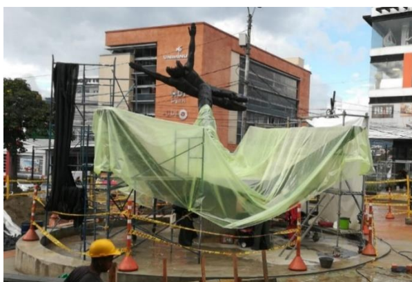
Fotografía 106 y 107. Instalación de andamios y cerramiento
