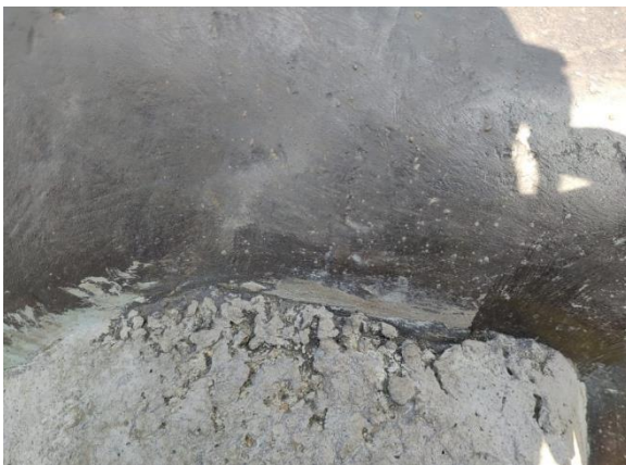
Fotografía 110 y 111. Eliminación de excesos de concreto en la unión con la columna
