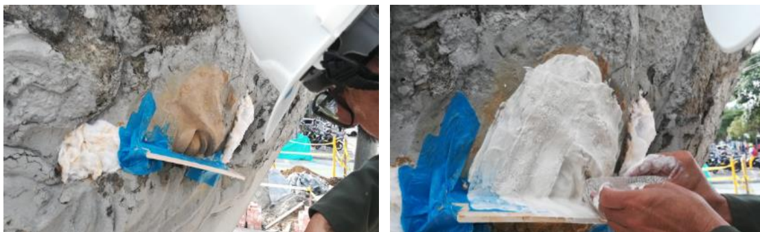
Fotografía 160 y 161. Elaboración de moldes para recuperación de figuras perdidas
