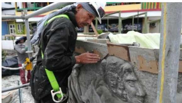
Fotografía 149 y 150. Instalación de formaletas y aplicación de Sika concrelisto RE-5000
