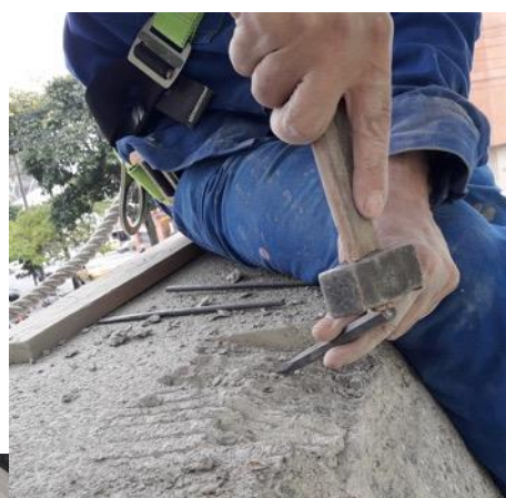
Fotografías 147 y 148. Retiro de material para corrección de pendiente en los bordes superiores de los trapecios
