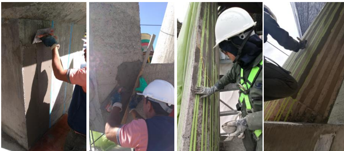
Fotografía 151 a 154. Aplicación de mortero en superficie de concreto
