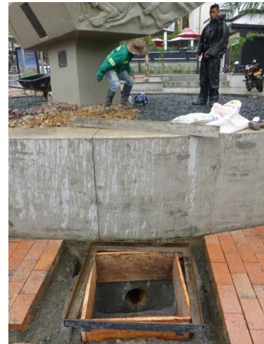
Fotografía 194. Caja de desagüe jardinera
