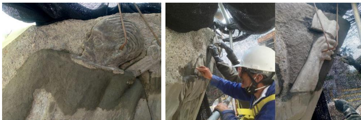
Fotografía 173 a 175. Aplicación de material para resanes profundos en los relieves
