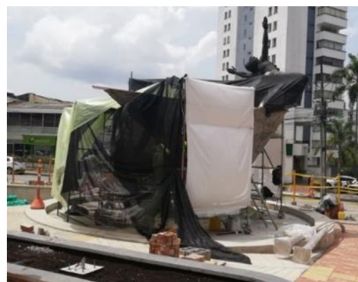
Fotografía 106 y 107. Instalación de andamios y cerramiento
