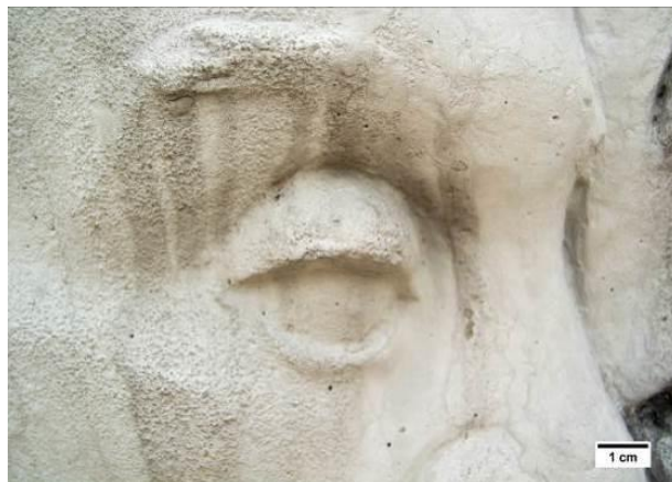
Fotografía 38. Manchas ocasionadas por escurrimientos de agua que arrastran suciedad y material particulado dejando una huella muy notoria en la superficie de la obra.
