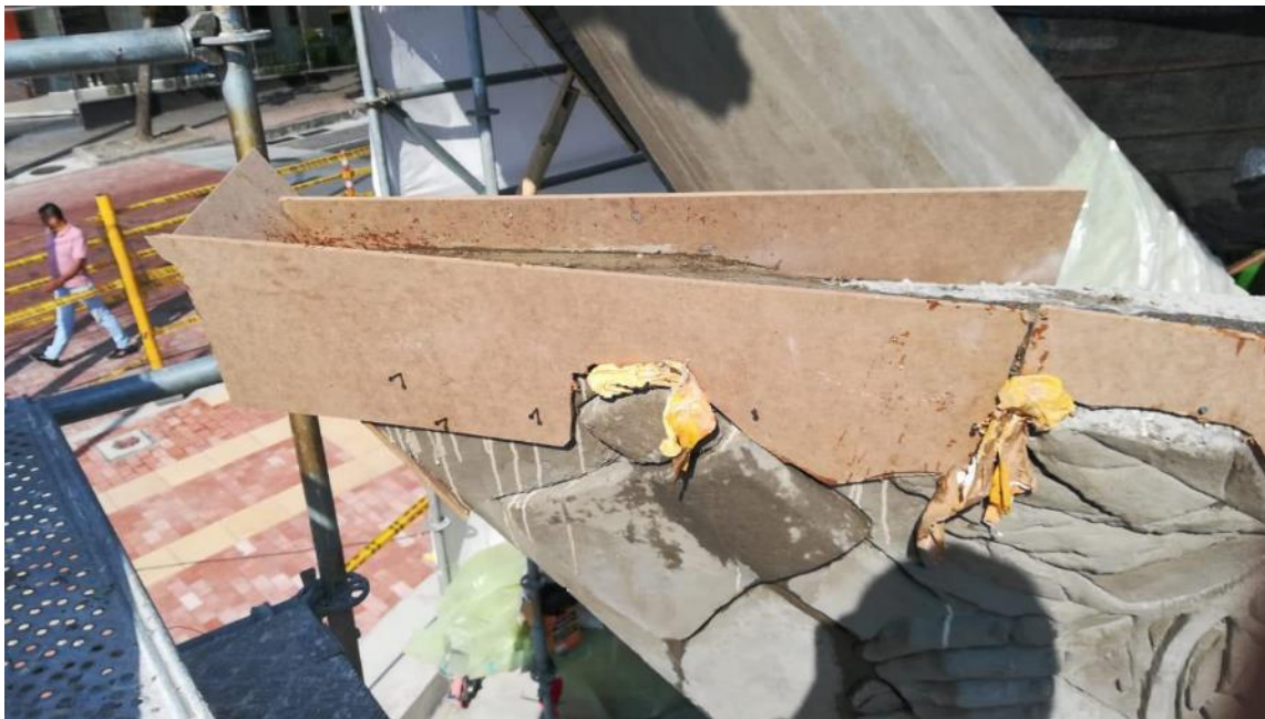
Fotografía 146. Ubicación de formaletas y vaciado de material de restitución para estas zonas
