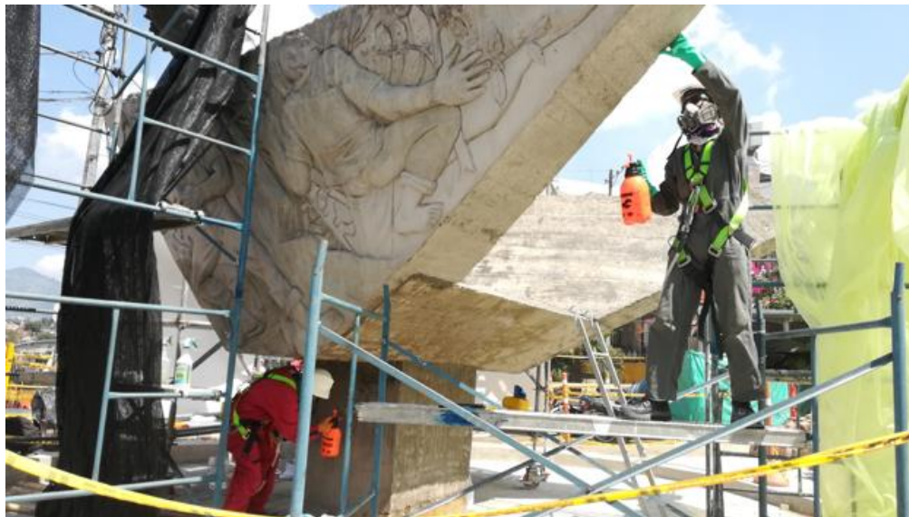
Fotografía 134. Aplicación de Sikaferrogard 903 sobre todas las superficies de concreto
