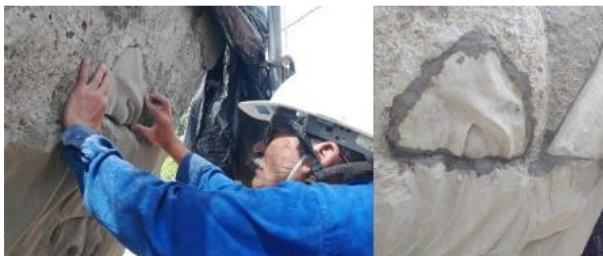
Fotografía 171 y 172. Ubicación de la figura de reposición sobre el concreto, el mortero de reparación ST122 permite la adherencia de la figura.
