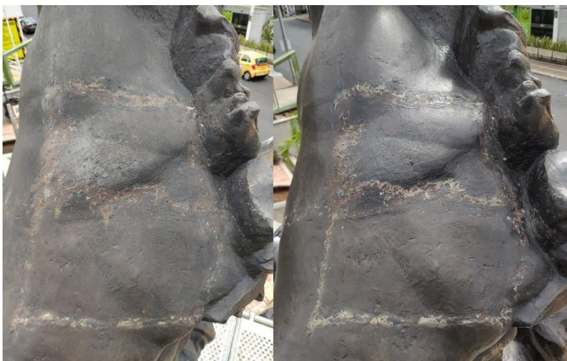
Fotografía 112 y 113. Proceso de limpieza, eliminación de suciedad superficial
