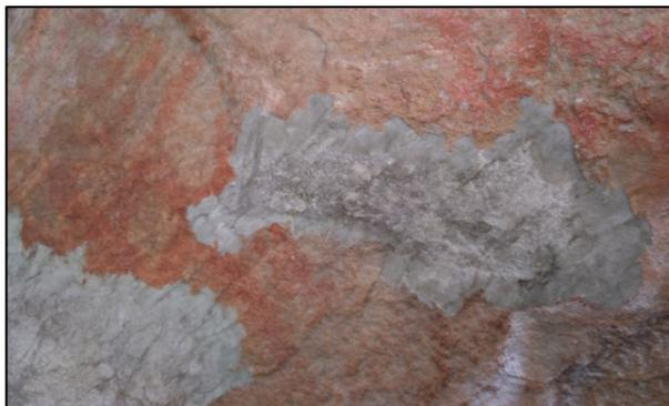
**Fotografía 48** Detalle del faltante que evidencia la delaminación presente en el soporte pétreo.
