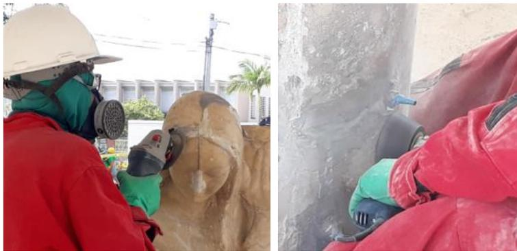
Fotografía 99 y 100. Proceso de eliminación de resina epóxica y de
