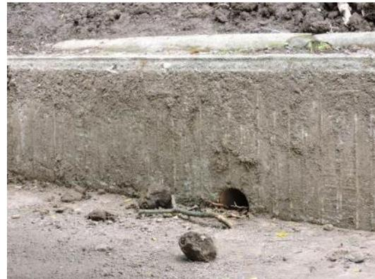
**Fotografía 21.** Desagüe lateral de la pileta
