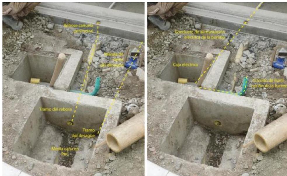
Ilustración 31. Conformación de las cajas de inspección hidráulica y eléctrica
