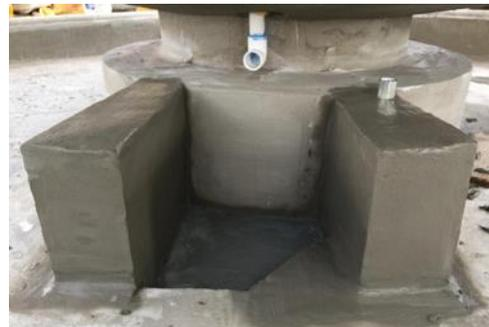
**Fotografía 165 y 166. Construcción de muros de la caja**
