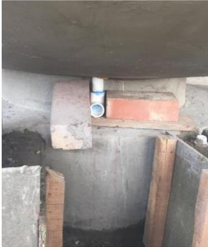
**Fotografía 158 y 159. Instalación hidráulica que conduce el agua de la motobomba a la taza, se observa el pase y sello en la taza**
