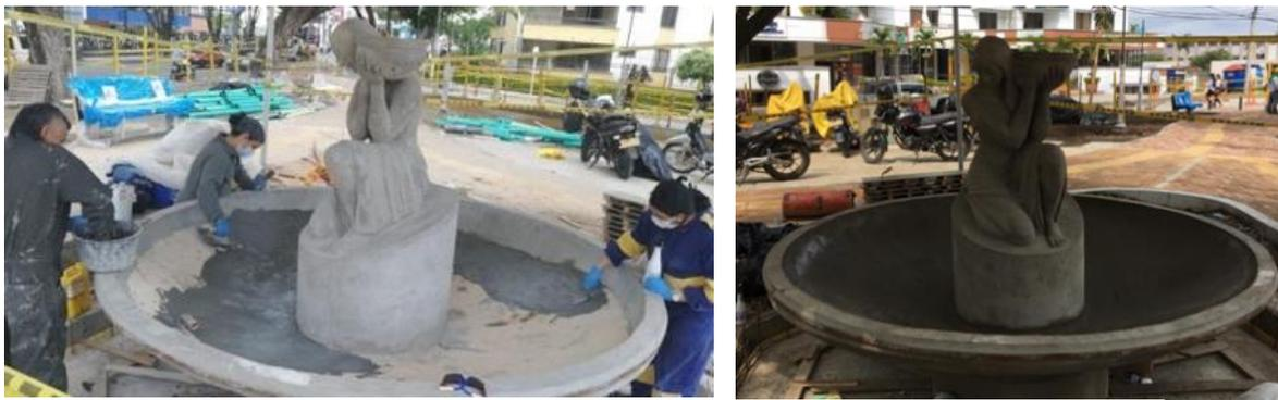
Fotografía 136 y 137. Aplicación de morteros de reparación y de impermeabilización en el interior de la taza
