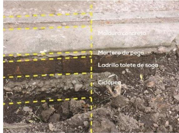
**Fotografía 19.** Vista cenital de los muros de la pileta donde se pueden ver el muro original (ciclópeo, ladrillo y moldura) y el muro interior de la pileta (capa superior de la foto)
