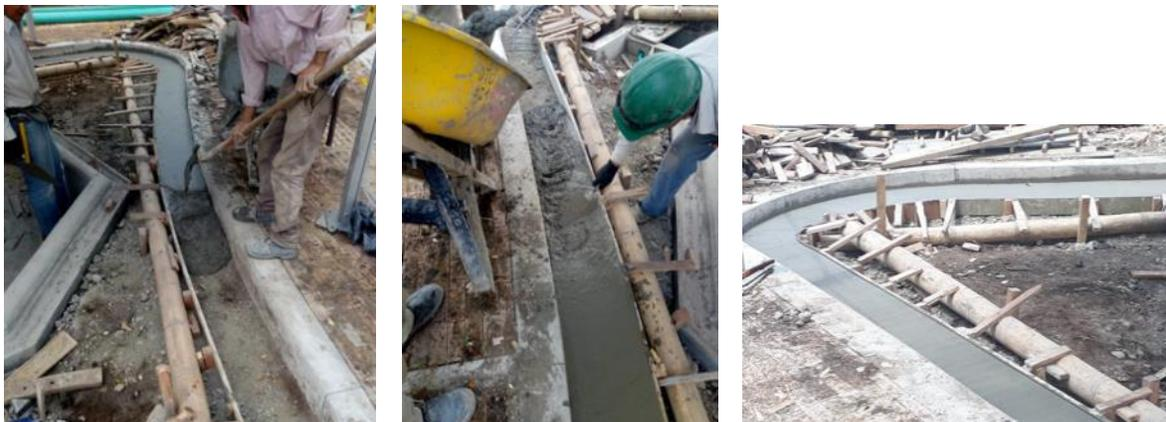
Fotografía 178 y 180. Proceso de construcción de escalón interior
