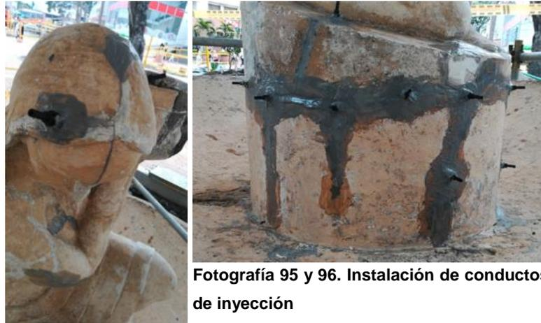
Fotografía 95 y 96. Instalación de conductos de inyección
