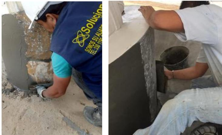
Fotografía 110 y 111. Aplicación en la peana de mortero de reparación grueso y de impermeabilización
