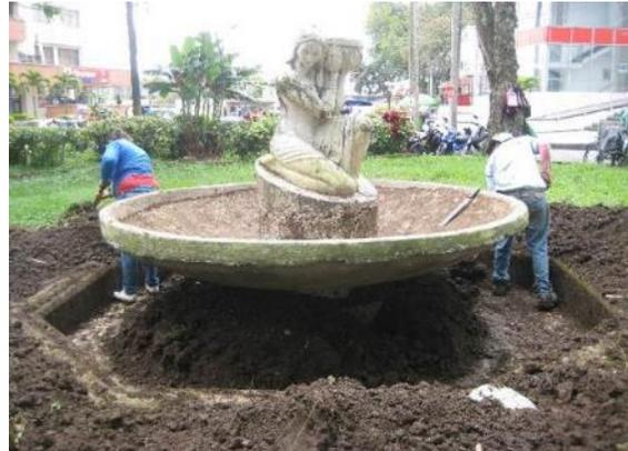
Fotografía 67 y 68. Vista general durante y después del proceso de retiro de tierra y vegetación al interior de la pileta octogonal
