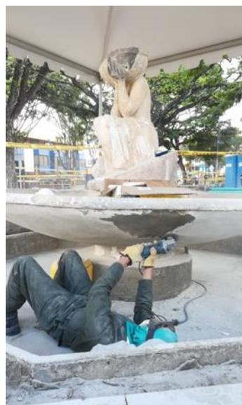
Fotografía 86 y 87. Eliminación de repintes con microabrasímetro y pulidora
