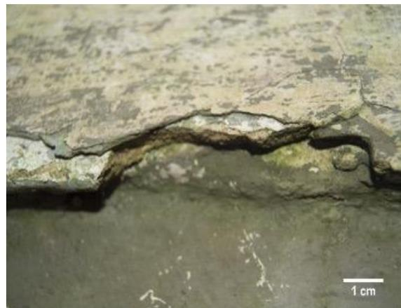
**Fotografía 64.** Reborde externo de la pileta circular, en la foto de la derecha se puede ver un faltante en este resane que deja en evidencia el grosor de este.
