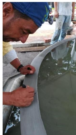
Fotografía 168 y 169. Caída inicial del agua de la taza a la pileta y comprobación de la estanqueidad de los elementos de la Fuente
