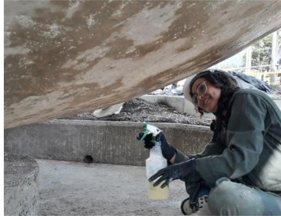
Fotografía 120 y 121. Aplicación de SikaFerrogard 903 en la parte superior e inferior de la taza
