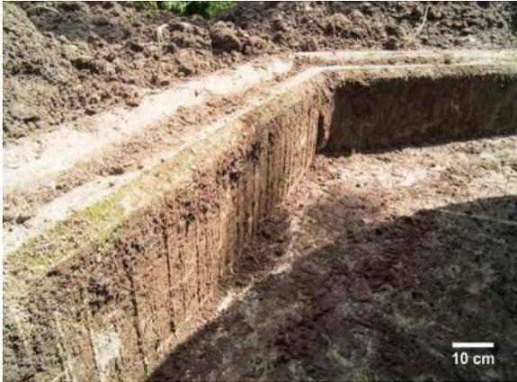
**Fotografía 18.** Muros perimetrales de la pileta con textura dada por la formaleta en madera utilizada en la fundición del más reciente. Piso en concreto.
