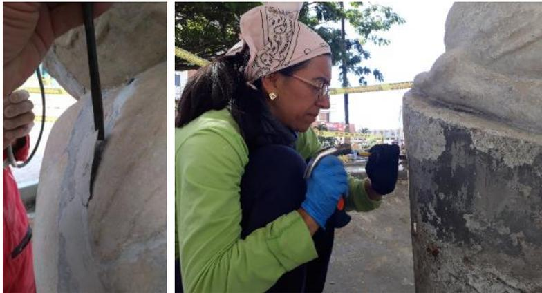
Fotografía 91. Eliminación de resanes en mal estado con cincel o pulidora
