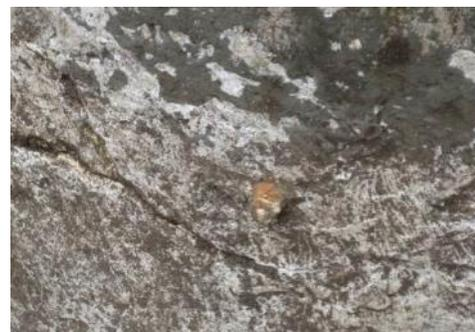
Fotografía 53. Elemento metálico con oxidación en la peana
