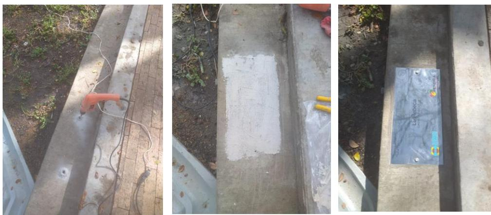
Fotografía 185 a 187. Proceso de instalación de la nueva placa en el andén perimetral contiguo a la Fuente
