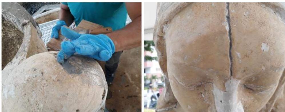
Fotografía 93 y 94. Aplicación de sellante de grietas en la cabeza, previo a la inyección
