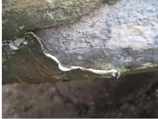
Fotografía 65. Detalle en zona de faltante que deja ver el grosor del reborde, así como las intervenciones anteriores que se encuentran por debajo de éste
