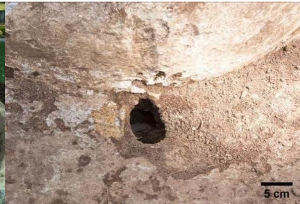
Fotografía 14. Detalle del desagüe en la taza
