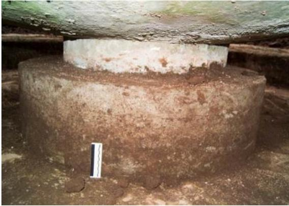
**Fotografía 15. Parte inferior de la taza, reposando sobre la base y la cinta perimetral**
