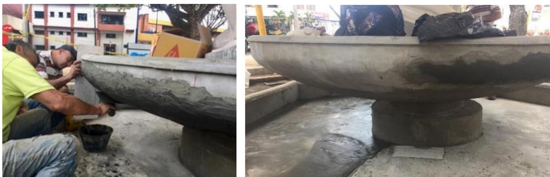
Fotografía 138 y 139. Aplicación de morteros de reparación y de impermeabilización en el exterior de la taza
