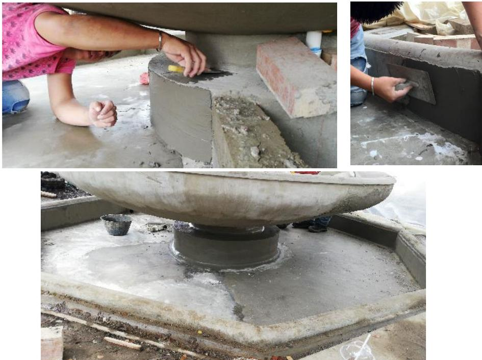
Fotografía 153 a 155. Aplicación de recubrimientos impermeabilizantes en muros de base, pileta y piso de pileta
