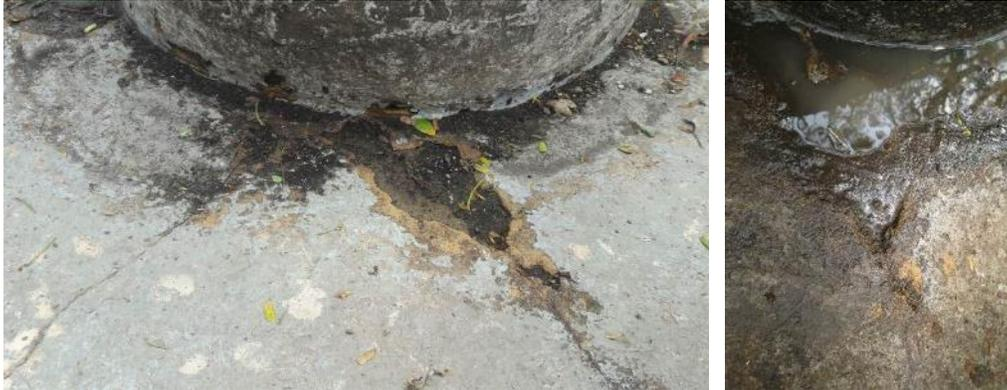
**Fotografía 58 y detalle. Erosión a lo largo de la superficie, donde el deterioro está en un nivel muy avanzado se genera empozamiento de agua**
