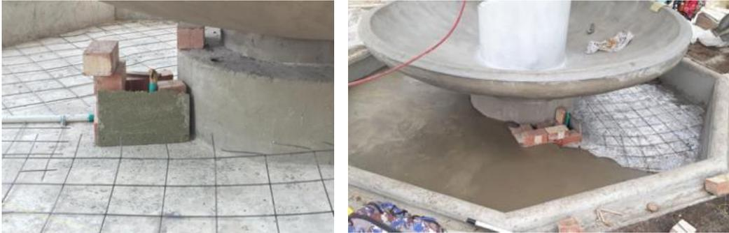
Fotografía 151 y 152. Tendido de malla electrosoldada y nivelación de piso de pileta
