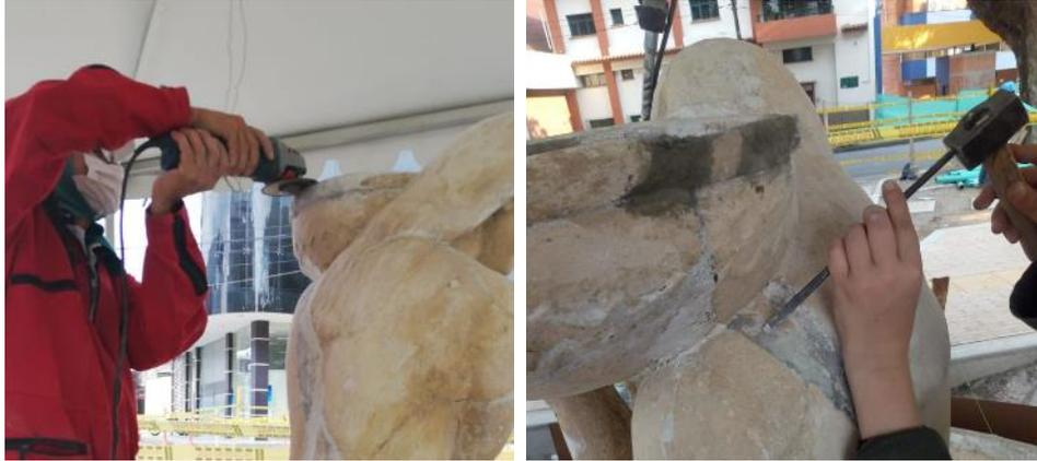
Fotografía 89 y 90. Eliminación de resanes en mal estado con cincel o pulidora
