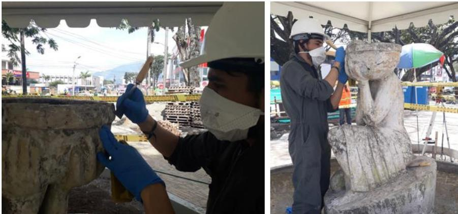
Fotografía 82 y 83. Raspado de primeras capas de pintura suelta con espátula metálica
