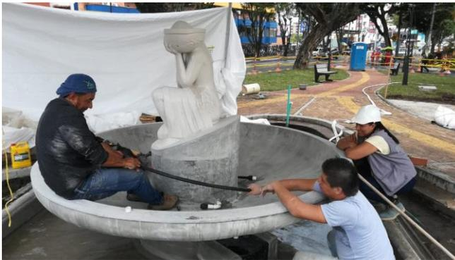
**Fotografía 160 y 161. Instalación y adecuación de manguera distribuidora del agua en la taza**
