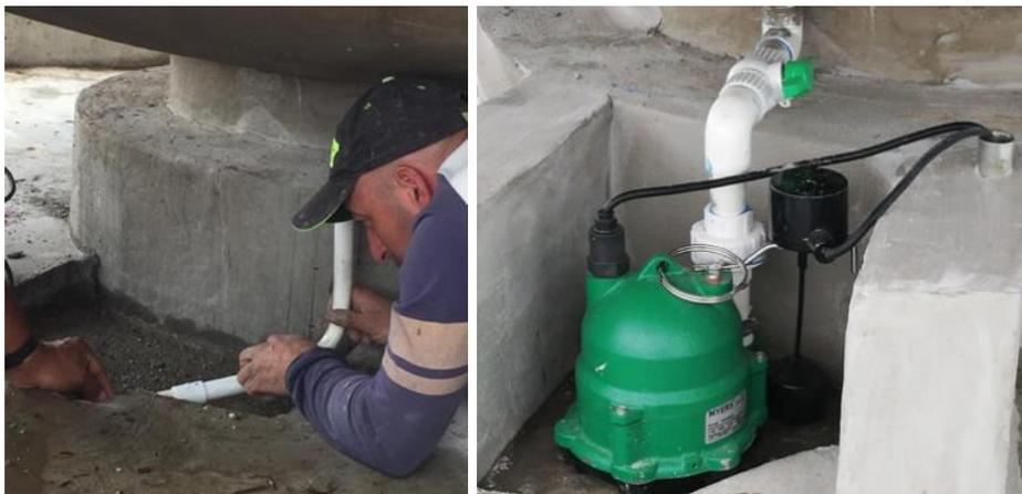
Fotografía 156 y 157. Instalación de alimentación eléctrica e hidráulica de motobomba
