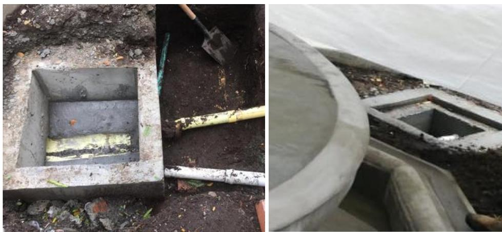
Fotografía 162 y 163. Conformación y ubicación de las cajas de inspección
