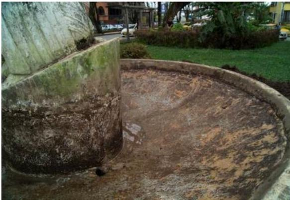
Fotografía 13. Taza con reborde donde se observa cerca a la peana un orificio que sirve de desagüe
