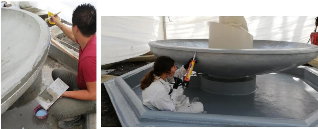
Fotografía 134 y 135. Acabados en el borde de la taza, aplicación de mortero impermeabilizante y sello
