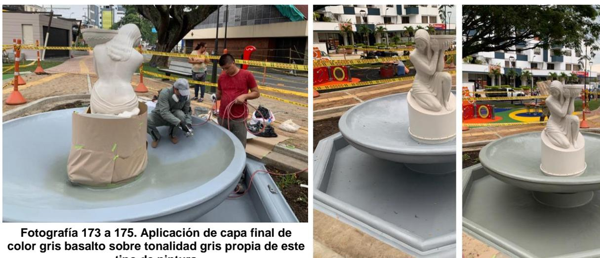
Fotografía 173 a 175. Aplicación de capa final de color gris basalto sobre tonalidad gris propia de este tipo de pintura
