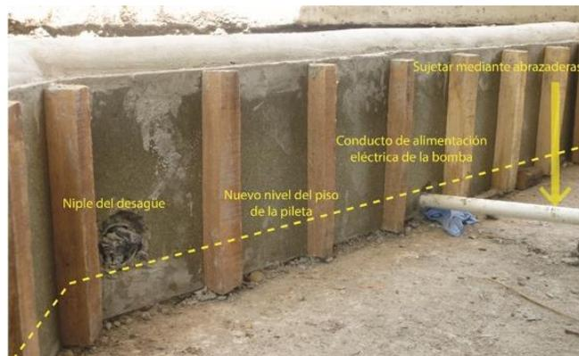
Ilustración 30. Conducto de alimentación eléctrica de la bomba sumergible
