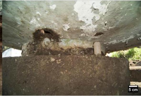
**Fotografía 16. Sobre la taza se observan el desagüe de bordes rugosos, el pase sellado y restos de la tubería de alimentación.**
