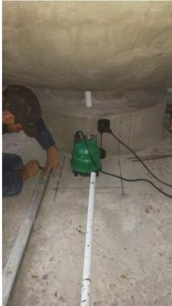
**Fotografía 164. Proceso de replanteo del área para la caja de la motobomba.**
