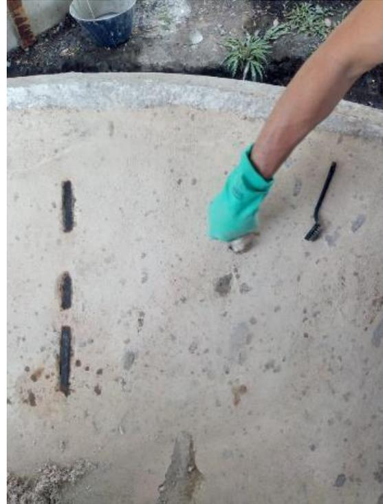
Fotografía 122 y 123. Eliminación de concreto suelto y Aplicación de SikaFerrogard 903 en las barras de acero con corrosión parte de la estructura metálica de la taza
