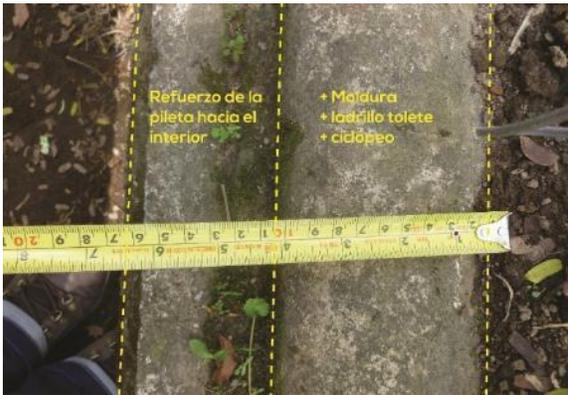
**Fotografía 20.** Vista cenital de los dos muros perimetrales de la pileta, el original con moldura a la derecha y el agregado a la izquierda.
