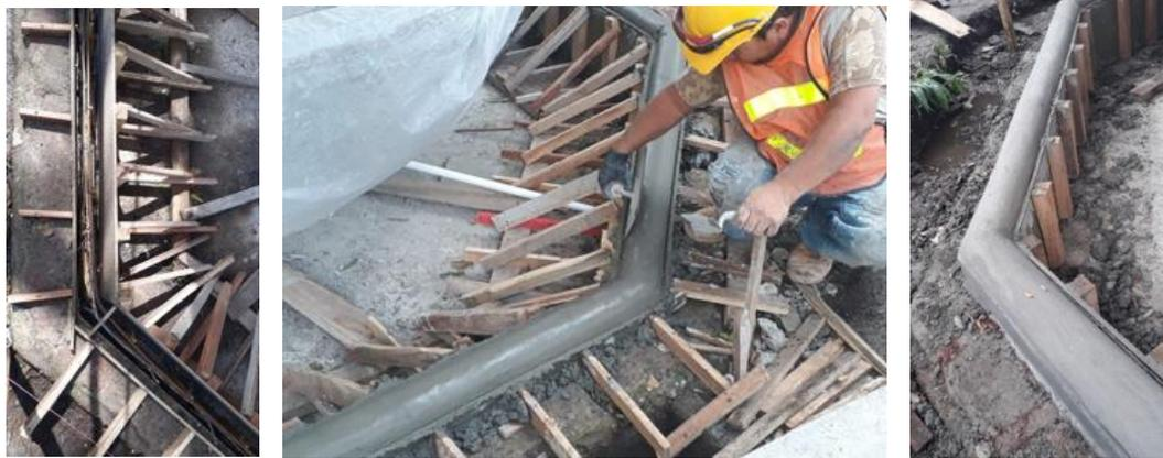
Fotografía 144 a 145. Conformación de la formaleta y la moldura
