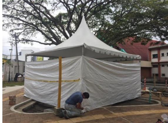
Fotografía 76 y 77. Cintas de seguridad y cerramiento usado en época de lluvias.
