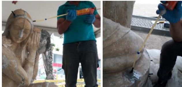
Fotografía 97 y 98. Proceso de Inyección de fisuras
