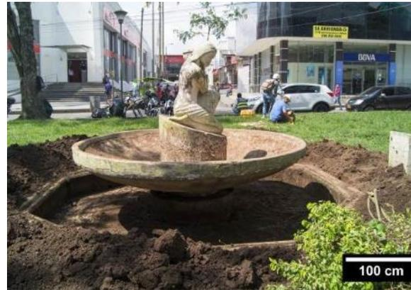
Fotografía 12. Vista lateral que permite evidenciar la forma irregular de la taza dada por el borde con alturas diferenciales
