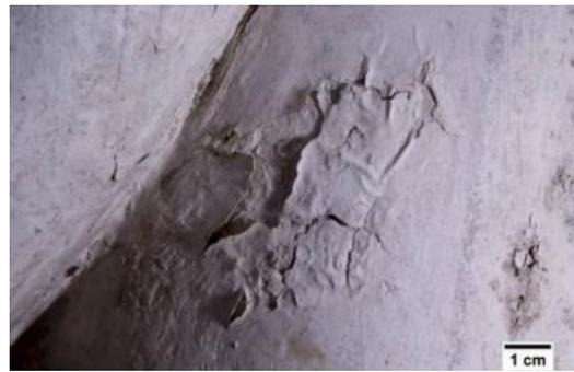
Fotografía 37 a 40. Detalles de ampollas y desprendimientos de capas de intervenciones anteriores
