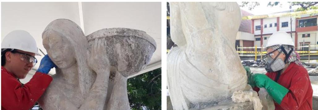
Fotografía 84 y 85. Eliminación de repintes con bisturí y aplicación de thinner con aspersor
