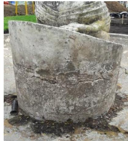
Fotografía 9. Peana cilíndrica cortada
