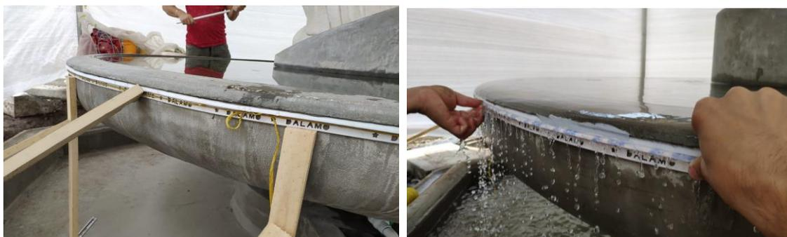
**Fotografía 132 y 133. Ampliación de la gotera del borde**
