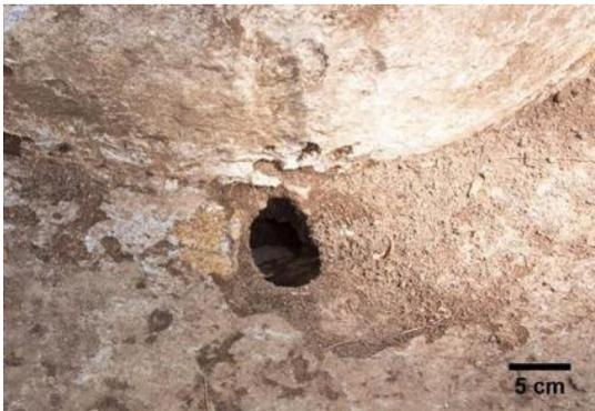
Fotografía 66. Perforación de forma irregular que sirve de desagüe
