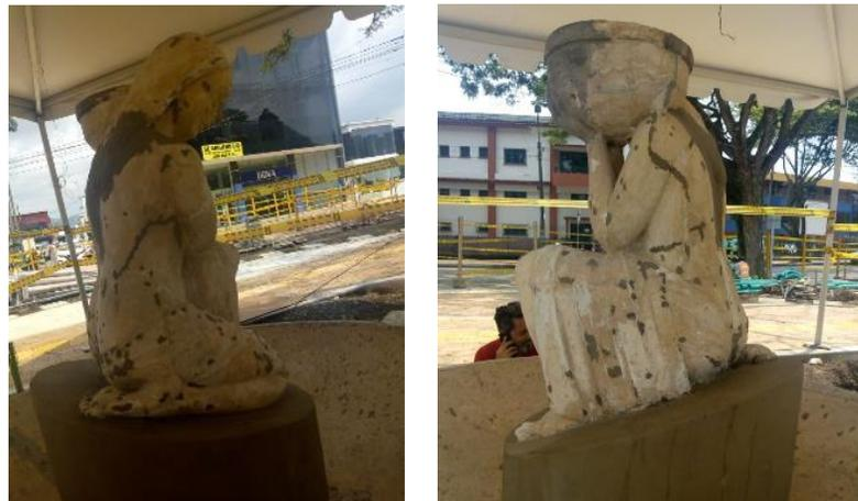
**Fotografía 105 a 106. Resanes con mortero de reparación**
