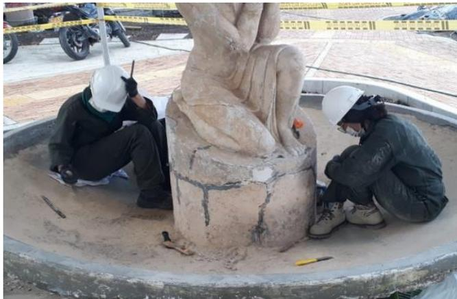
Fotografía 117. Eliminación de repintes y concreto suelto y en mal estado
