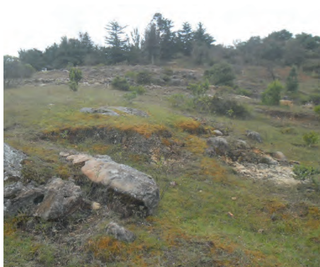
Foto 36. Erosión costado noreste del predio. Foto: Álvaro Botiva Contreras.
