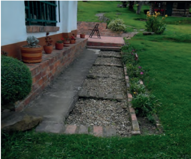
Foto 23. Zona de drenaje casa principal. Foto: Álvaro Botiva Contreras.
