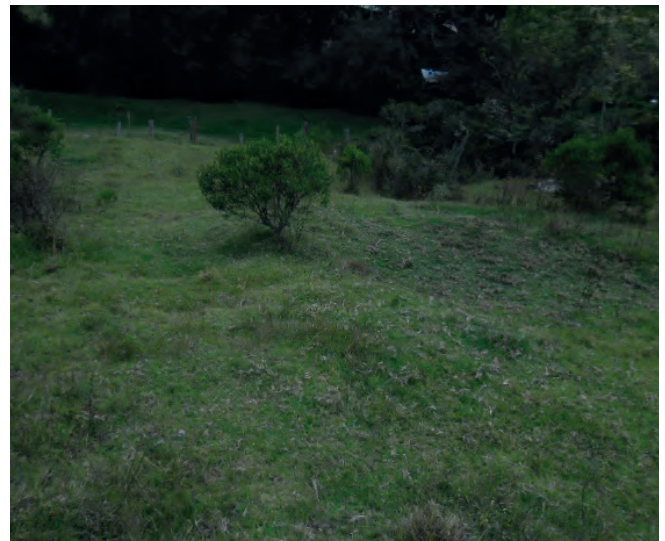
Foto 49. Pendiente con hundimiento del terreno. Foto: Álvaro Botiva Contreras.
