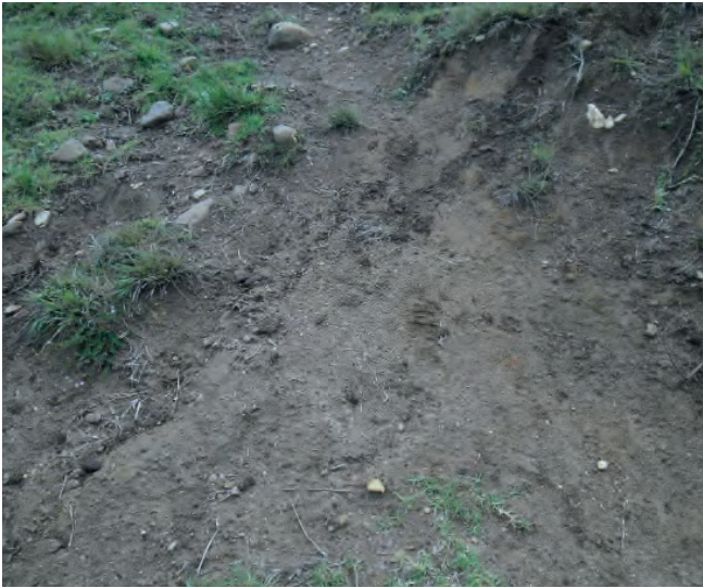
Foto 39. Erosión costado sur oeste del predio. Foto: Álvaro Botiva Contreras.
