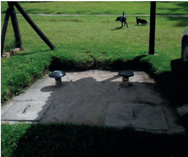
Foto 24. Plancha de concreto de uno de los pozos sépticos. Foto: Álvaro Botiva Contreras.
