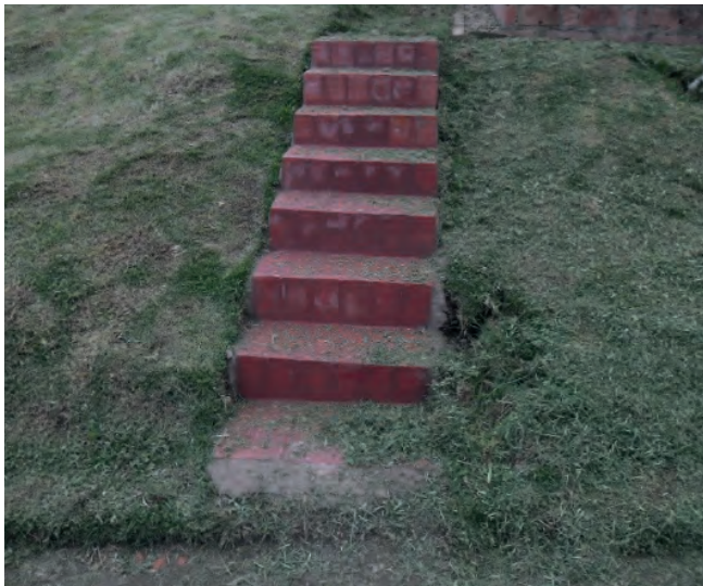
Foto 6. Escaleras de acceso a la casa principal. Foto: Álvaro Botiva Contreras.
