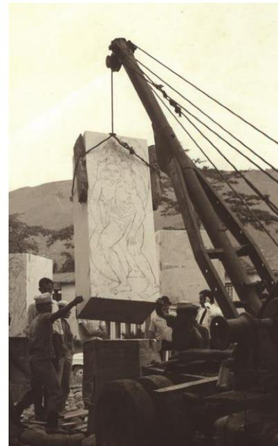
*Proceso de montaje de los bloques de mármol sobre las bases de ladrillo y cemento en el lugar escogido por Pedro Nel Gómez para el Tótem Mítico*
