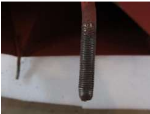
Foto 8: Modificación varilla soporte (roscado).
