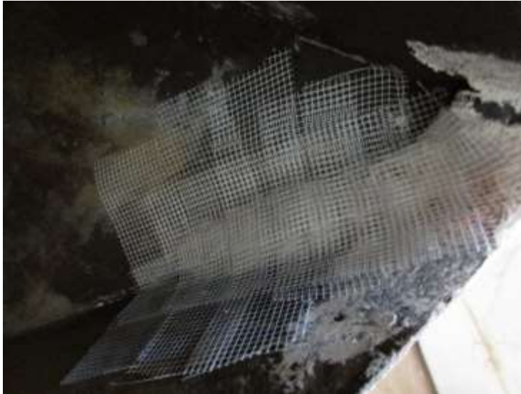
Foto 9: Refuerzo interno con fibra de vidrio y masilla epóxica
