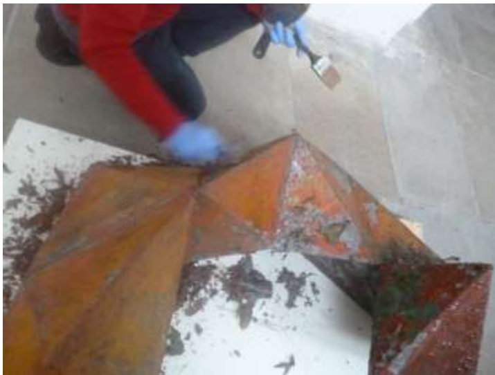
Foto 4: Proceso eliminación pintura con espátula.
