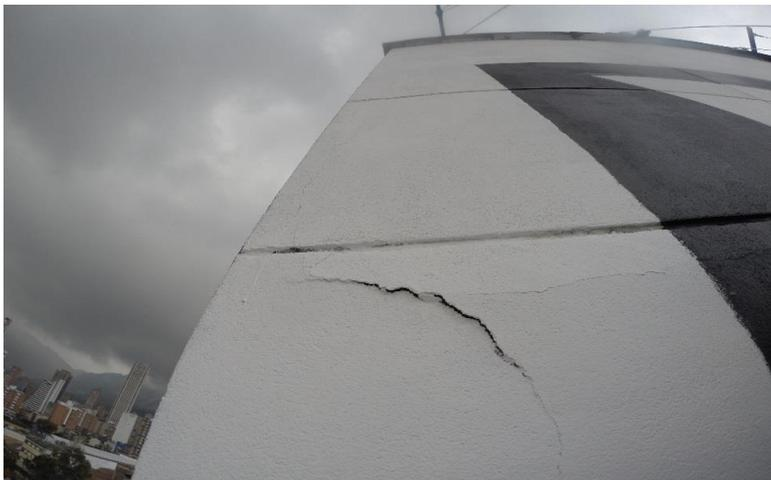
*Imagen 30.* Detalle de una placa con abombamiento en el mural Nudobilia X
