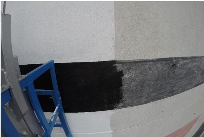
Imagen 36. Aplicación de capas de color negro que permiten cubrir la mayoría de fisuras.
