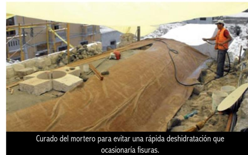
Curado del mortero para evitar una rápida deshidratación que ocasionaría fisuras.
