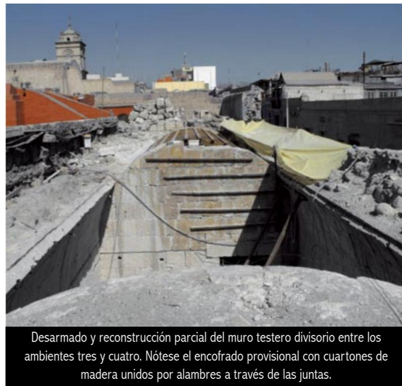
Desarmado y reconstrucción parcial del muro testero divisorio entre los ambientes tres y cuatro. Nótese el encofrado provisional con cuarterones de madera unidos por alambres a través de las juntas.
