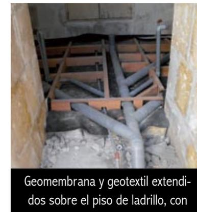
Geomembrana y geotextil extendidos sobre el piso de ladrillo, con encasetonado de madera donde se colocan las tuberías para que no toquen los pisos originales, con el objeto de lograr una intervención reversible.
