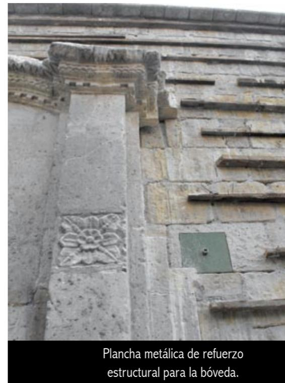
Plancha metálica de refuerzo estructural para la bóveda.
