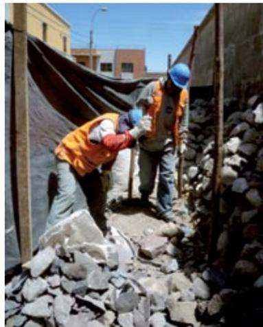
Partiendo piedra de río del núcleo original, para cuñas de dovelas y piedra de relleno para el núcleo.
