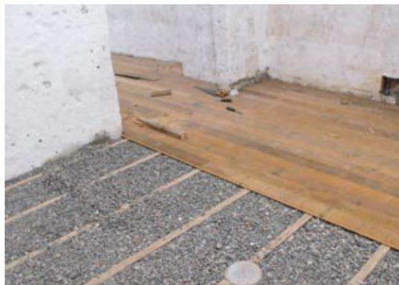
Proceso de instalación de piso con madera de pino Oregón sobre cuarterones de madera arriostrados al piso y cascajillo de relleno.
