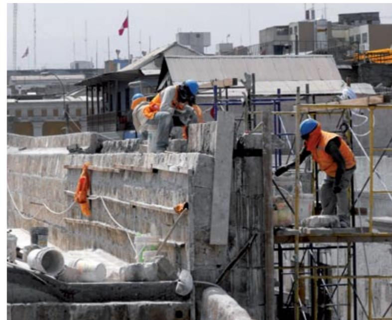
Rearmado del remate del muro. Nótese los encofrados provisionales con cuartones de madera, para mantener las piezas en su lugar durante el proceso de relleno del núcleo.
