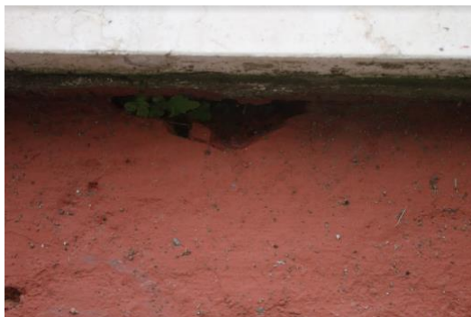
Fotografía 21. Crecimiento de plantas que han generado faltantes de soporte en peana, en el ángulo creado entre esta y la placa.
