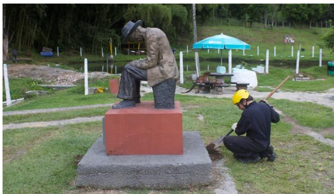
Fotografía 41. Excavación y verificación anclaje.
