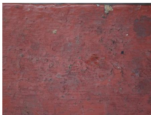
Fotografía 29. Faltantes pequeños y fisuras en pintura de peana.
