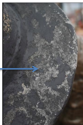
Fotografía 36. Faltante restituido a partir de cemento gris el cual presenta características que difieren del soporte original como dureza y textura. 2019.
