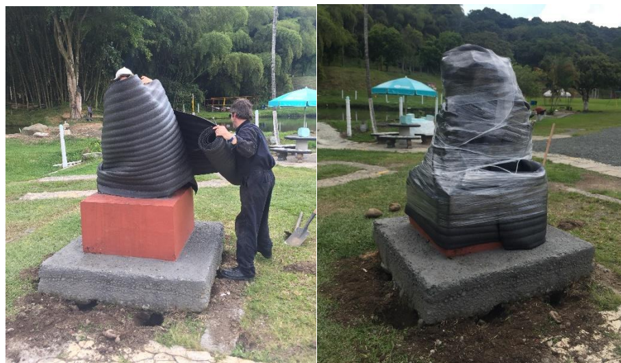
Fotografía 42 y 43. Protección escultura, peana y pedestal.
