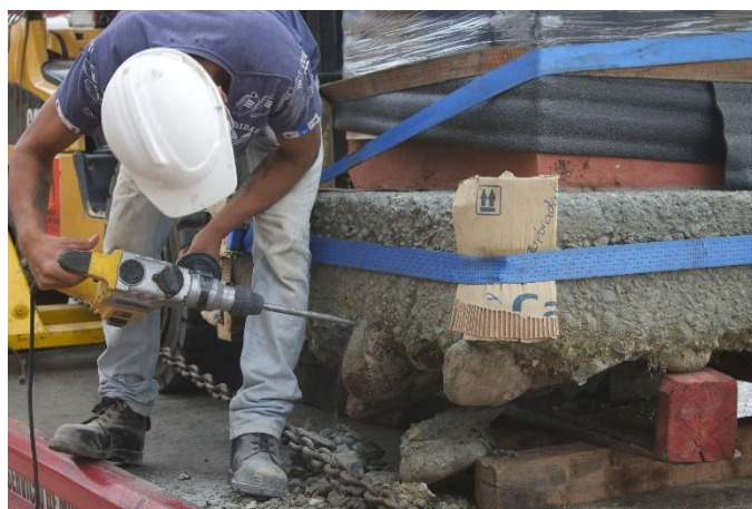
Fotografía 48. Eliminación de las piedras adheridas al pedestal.
