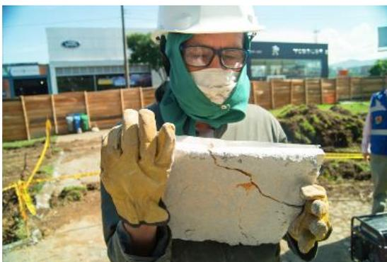
Se realiza la demolición parcial de la parte superior del pedestal con la ayuda de cortadora metálica, macetas y cinceles y se logra separar la peana del pedestal. La peana se retira con la ayuda de las diferenciales y el montacargas y ésta se embala junto a la escultura.
