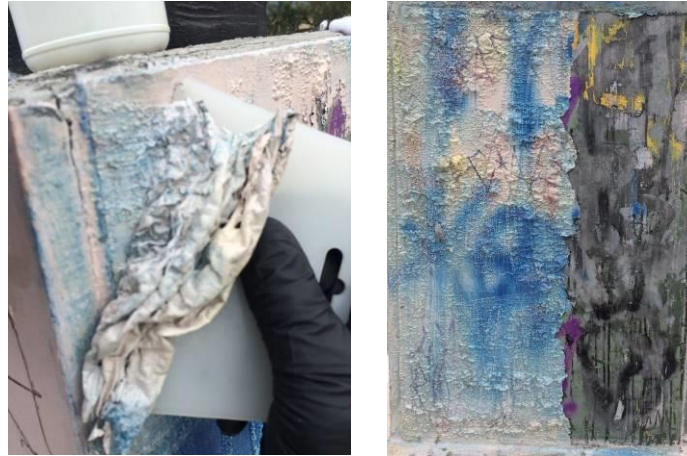
Fotografías 19 y 20. Eliminación de pintura acrílica sobre el pedestal.
