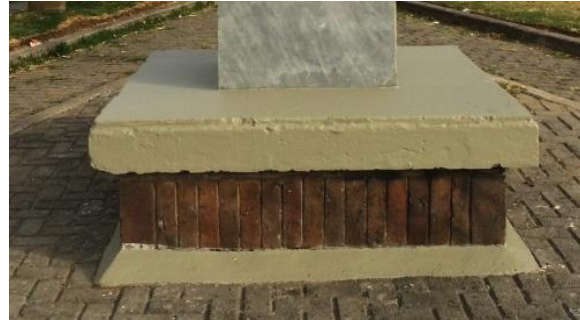
Fotografía 29. Enlucimiento del basamento.
