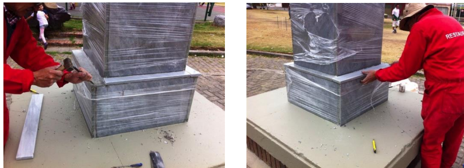
Fotografías 24 y 25. Restitución de faltantes de mármol.
