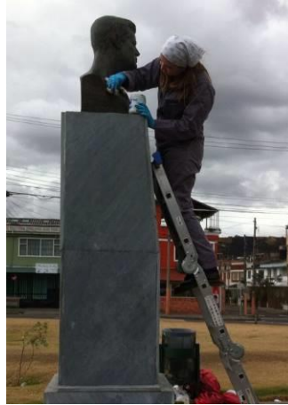
Fotografías 16 y 17. Proceso de aplicación de capa de protección.
