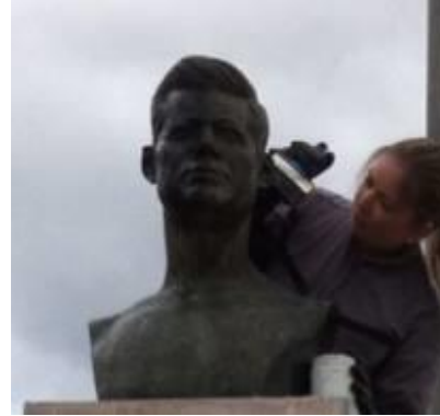
Fotografías 16 y 17. Proceso de aplicación de capa de protección.
