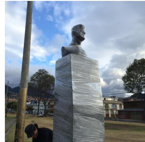
Imagen 15 detalle proceso de cubrimiento.
