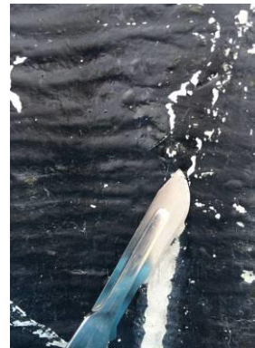
Fotografía 9. Detalle de eliminación de grafiti con bisturí
