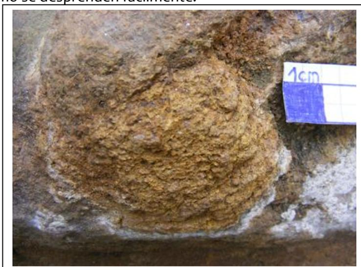
Figura 1: La foto muestra una zona dentro de la Fuente donde se observa el deterioro llamado decohesión. El área presenta más irregularidades mientras que los bordes aparecen más lisos, al tacto se desprenden partes mínimas de roca.
