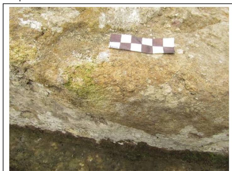
Figura 2: En la foto se presenta otra zona de la Fuente donde hay decohesión allí las irregularidades no resultan tan evidentes sin embargo la prueba al tacto permite corroborar la pulverulencia.
