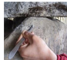
Eliminación de suciedad superficial y biodeterioro
