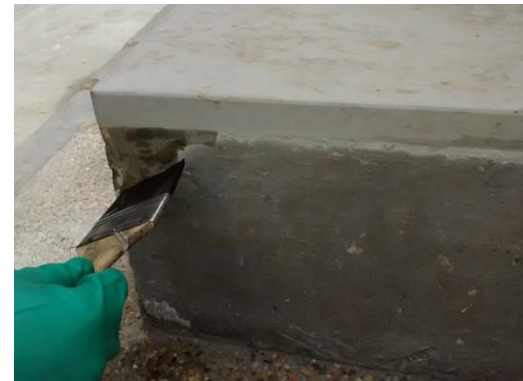
Fotografía 63. Aplicación de la veladura
