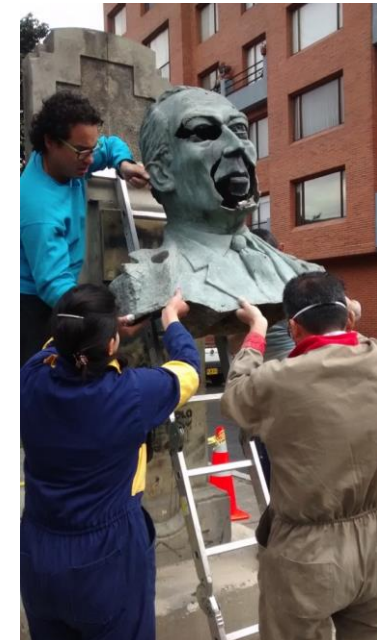
Fotografía 10. Desprendimiento final del busto.
