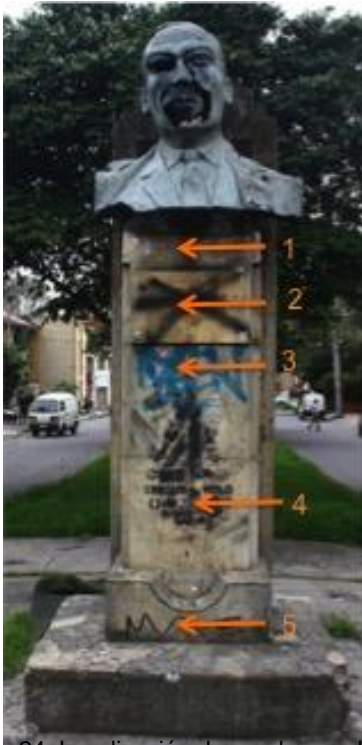
Fotografía 24. Localización de pruebas en la parte frontal del pedestal.
