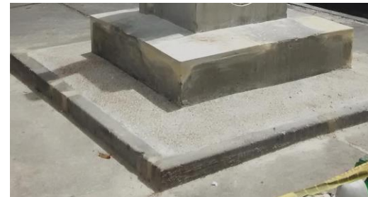
Fotografía 69. Basamento inferior luego de la intervención.
