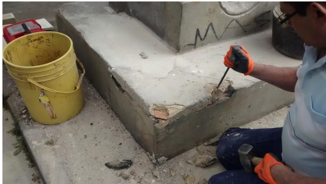
Fotografía 56. Eliminación del resane de basamento ubicado en la esquina frontal izquierda.
