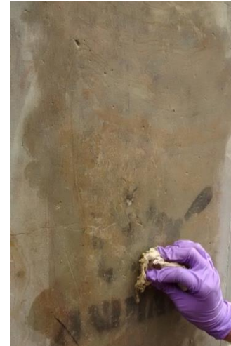
Fotografía 49. Aplicación del método mecánico para retirar grafitis.
