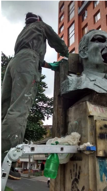
Fotografía 41. Proceso de limpieza superficial
