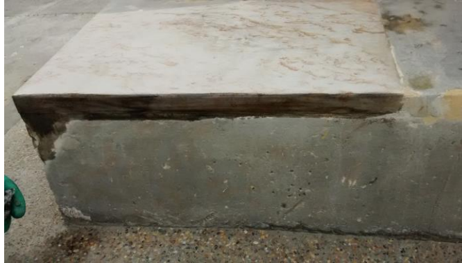
Fotografía 64. Aplicación de la veladura en el lateral
