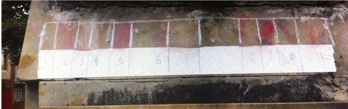
Fotografía 25. Prueba 1 antes de la limpieza
