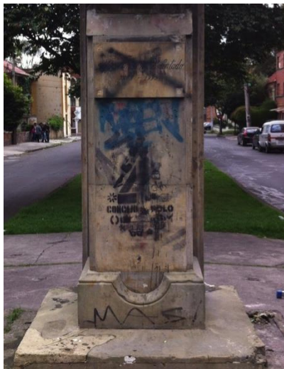
Fotografía 50. Pedestal vista previa a la limpieza
