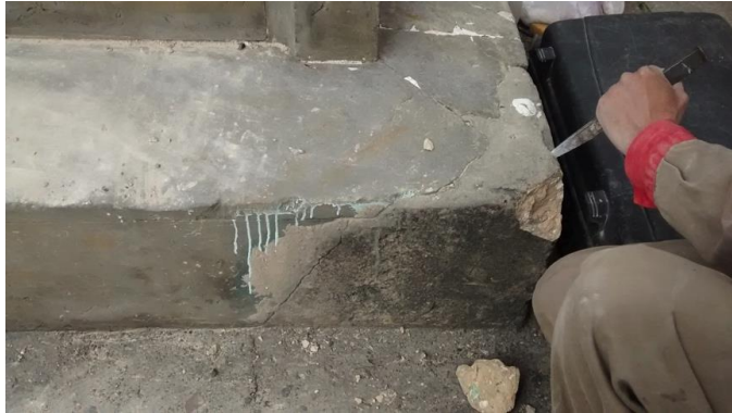
Fotografía 58. Eliminación del resane de la esquina frontal derecha.
