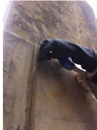
Fotografía 53 y 54. Proceso de resane y reintegración de juntas
