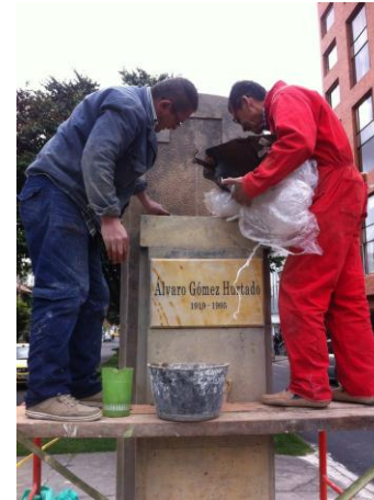
Fotografía 22. Ubicación de la escultura sobre el pedestal
