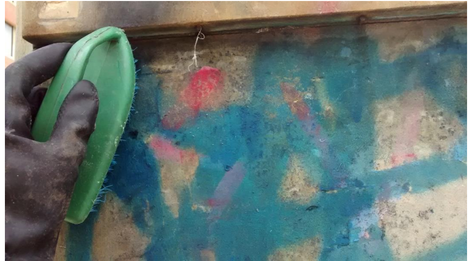
Fotografía 42. Proceso de limpieza con cepillo de cerda plástica.
