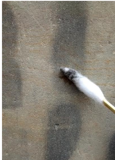
Fotografía 46. Limpieza con hisopo.
