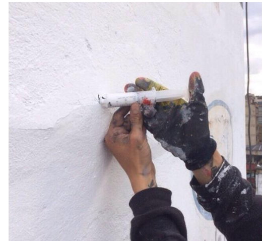
Imagen 47. Aplicación de estuco líquido con jeringa para rellenar el abombamiento
