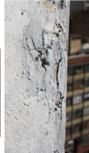
Imagen 34 a 37. Detalle de perforaciones e irregularidades en el pañete de cemento del mural Cundinamarrum.
