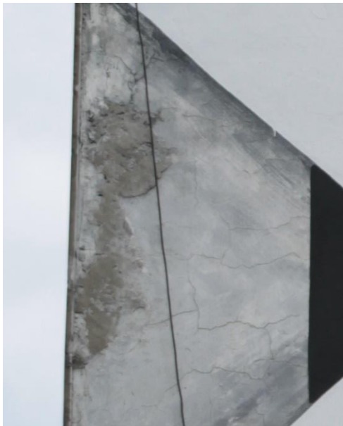
Imagen 40. Resane de cemento muy irregular en la parte central norte del mural
