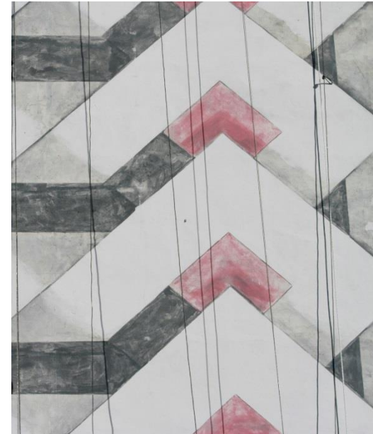
Imagen 32. Suciedad generalizada, abrasión y degradación de los colores en el mural Cundinamarrum.
