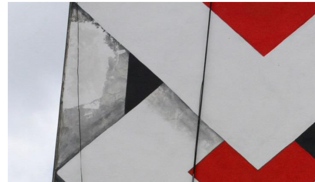
Imagen 42. Pulido y nivelado de la intervención anterior presente en el costado norte del mural
