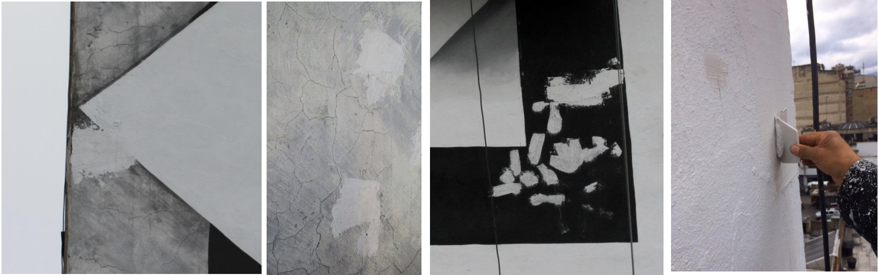
Imagen 43 a 46. Aplicación de estuco para cubrir las grietas más grandes.
