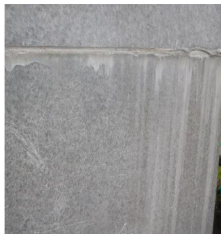
Fotografía 23. Detalle del pedestal con concreciones producto de la disolución del mortero de junta en una de las placas del anverso.
