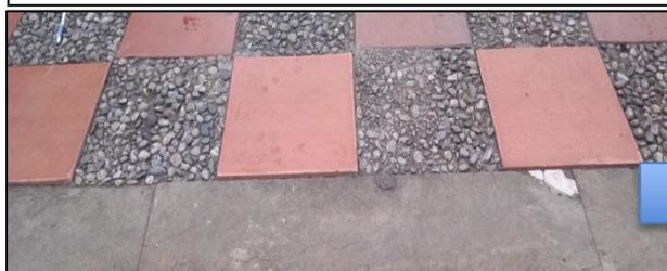
Fotografías 70 y 71: estado del piso cerámico y de gravilla lavada antes y después de la limpieza
