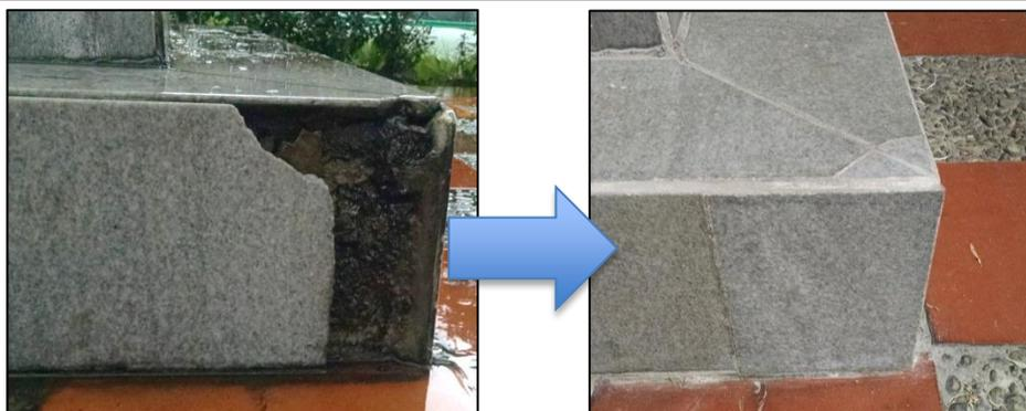
Fotografía 57 y 58: Antes y después de la restitución de enchape de mármol.
