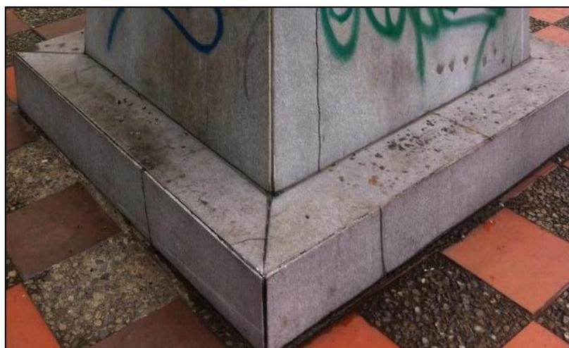
Fotografía 20. Basamento, se observa suciedad consistente sobre la superficie del enchapado, particularmente residuos de parafina y juntas deterioradas.
