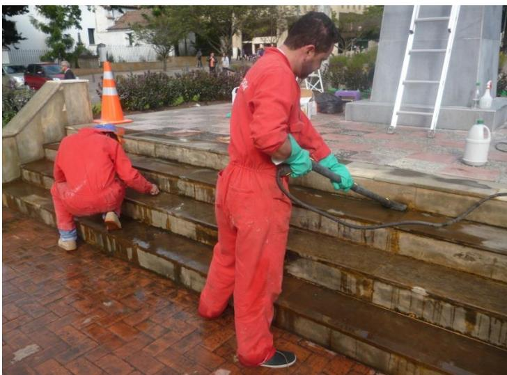
Fotografía 66: Limpieza del espacio público con máquina de vapor, agua y alcohol, cepillos y espátulas
