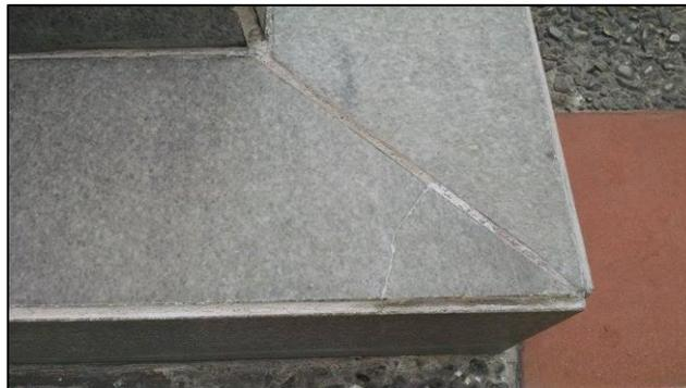
Fotografía 60: esquina noroccidental del basamento con enchape de mármol.
