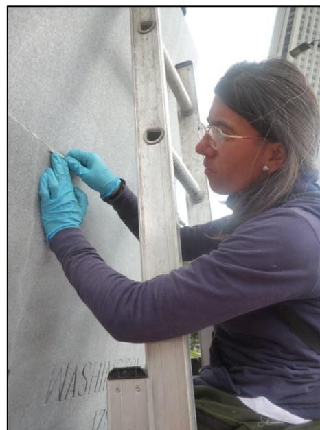
Fotografía 54 Eliminación de concreción de mortero disuelto con bisturí.
