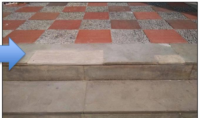
Fotografía 80 a 85: Fotos de detalle que ilustran el antes y después de la realización de injertos en los pasos de la escalera que da acceso al monumento a George Washington
