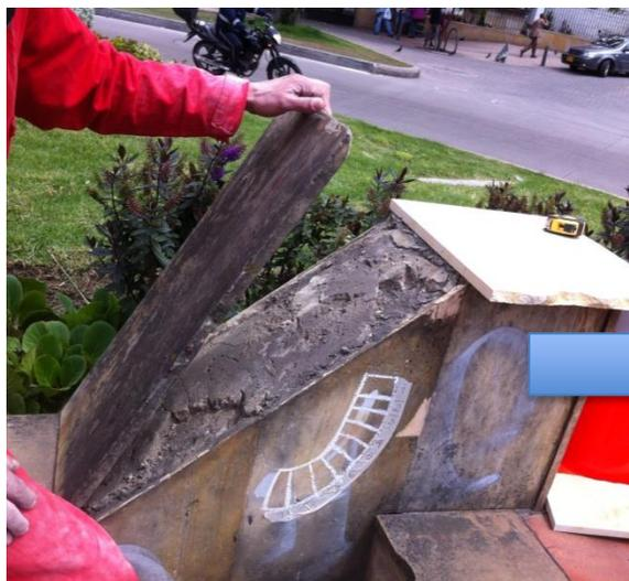
Fotografía 74 y 75: Aplicación de mortero de cemento y arena para adherir la laja suelta en el lateral norte de la escalera.
