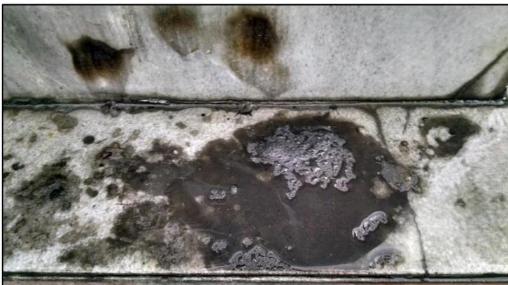
Fotografía 22. Detalle del basamento con residuos de parafina, manchas de hollín y fisura en el enchape.
