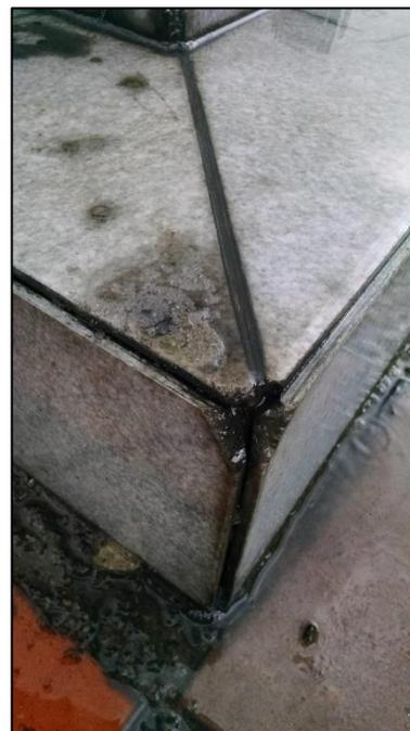
Fotografía 21. Suciedad consistente, juntas deterioradas y enchape desportillado
