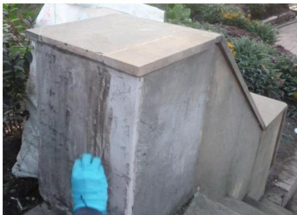
Fotografía 76: Reintegración con tizas de silicato de la laja donde fue eliminado el cemento con pulidora.
