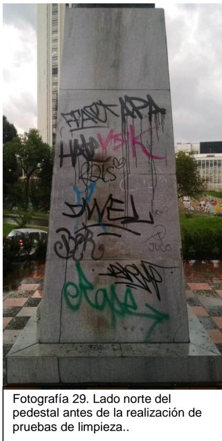
Fotografía 29. Lado norte del pedestal antes de la realización de pruebas de limpieza..
