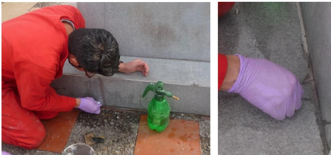
Fotografías 61 y 62: restitución de juntas deterioradas en el basamento. El mortero de unión fue también utilizado para rellenar las fisuras.
