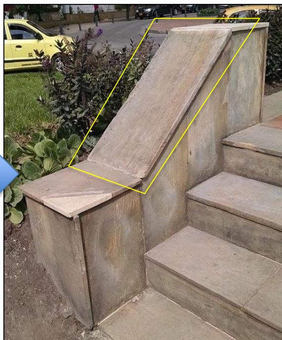
**Eliminación de cemento agregado en la laja del lateral sur de las escaleras:** En la laja del extremo oriental del lateral sur de la escalera se apreciaban acumulaciones de cemento que fueron eliminadas mecánicamente con pulidora, el color de la laja recién pulida fue reintegrado con tizas de silicato disueltas en agua.
