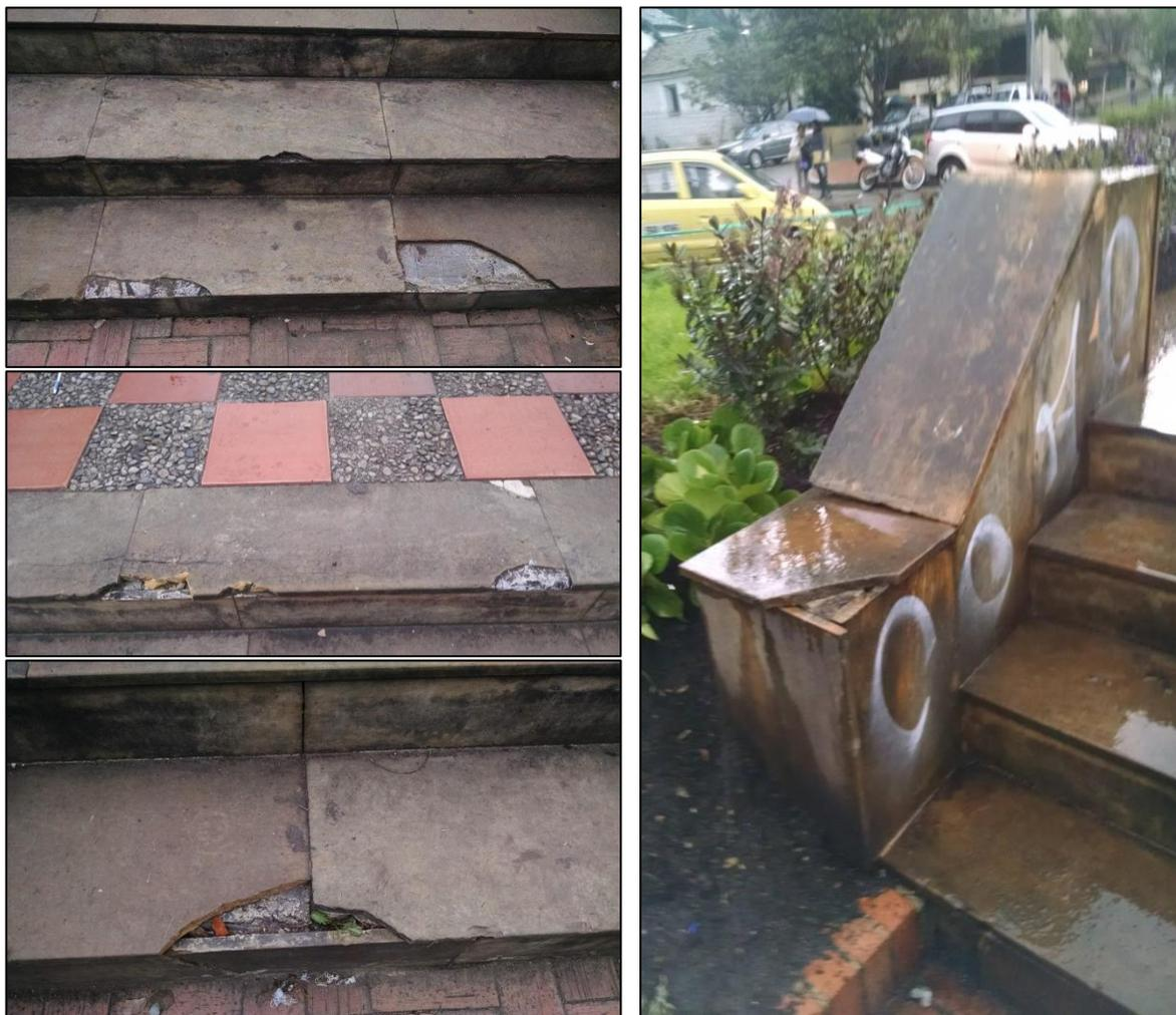
Fotografías 24, 25 y 28. Suciedad, desprendimientos, faltantes y grafitis en las escaleras y el piso del tableta y gravilla lavada.
