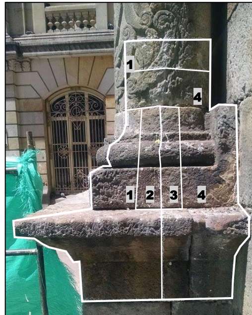
Figura 16: Área L5, Fotografía que registra el estado de conservación antes de las pruebas de limpieza.
