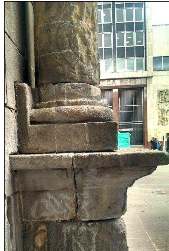
Figura 19: Área L6, Fotografía que registra el resultado de la limpieza con medios mecánicos, agua-alcohol 1:1 y vapor de agua)
