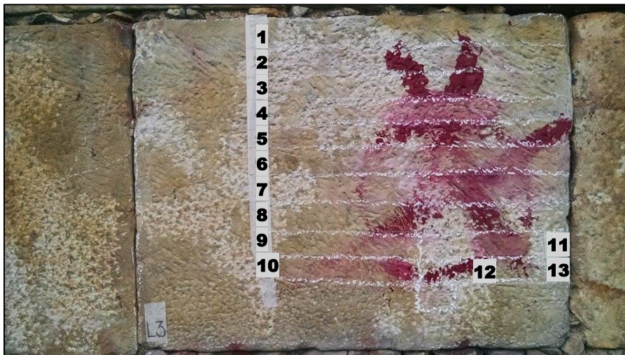
Figura 12 : Prueba de limpieza L3
