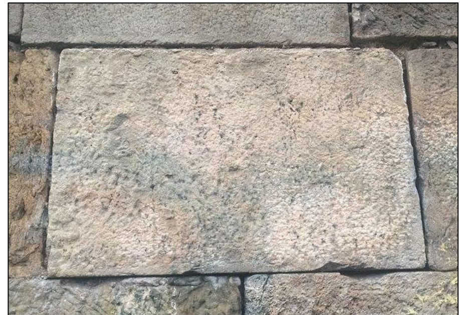
Figura 11: Área L2, Fotografía que registra el resultado de la limpieza de los grafitis de esta zona con el solvente seleccionado en las pruebas de limpieza (Quita grafiti en gel FORTE).
