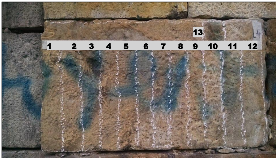
Figura 14: Prueba de limpieza L4
