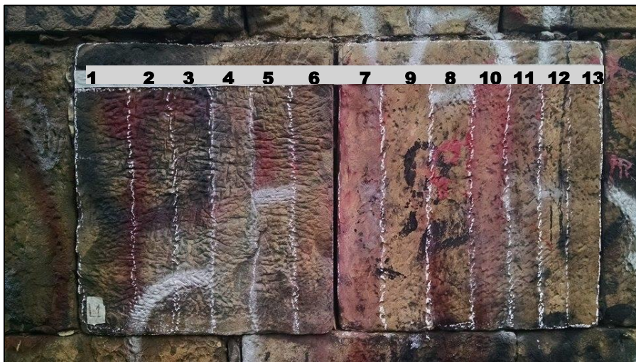
Figura 8: Prueba de limpieza L1
