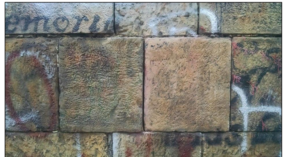
Figura 9: Área L1, Fotografía que registra el resultado de la limpieza de los grafitis de esta zona con el solvente seleccionado en las pruebas de limpieza (Quita grafiti líquido Tagaway).
