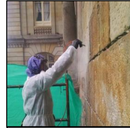
20. Tratamiento con microabrasímetro
