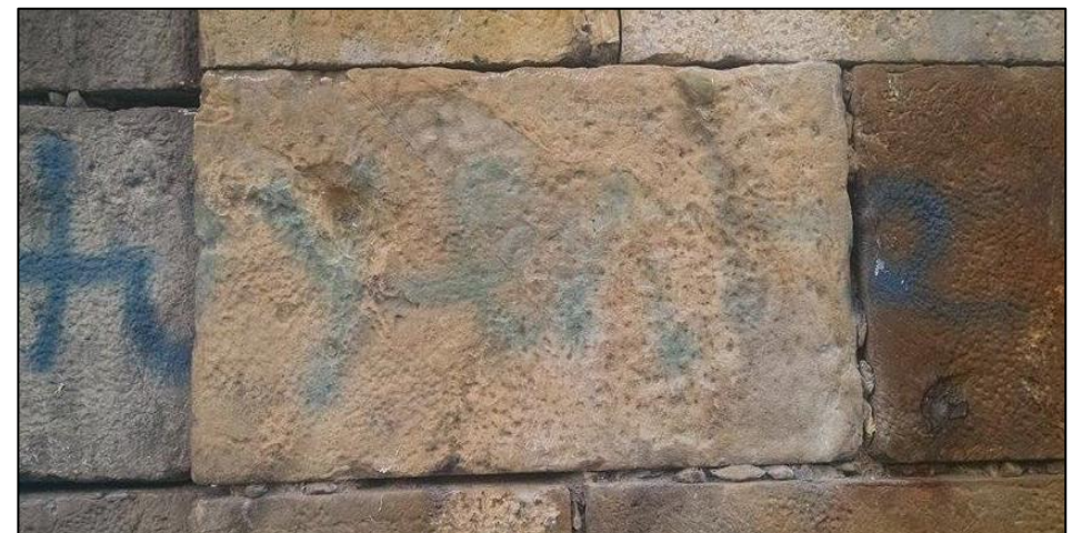
Figura 15: Área L4, Fotografía que registra el resultado de la limpieza de los grafitis de esta zona con el solvente seleccionado en las pruebas de limpieza (Quita grafiti en gel FORTE).
