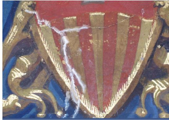
Fotografía N°27: Grieta rellena con mortero fino a la cal
