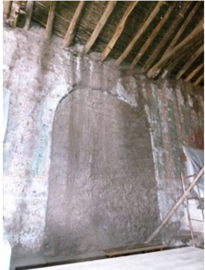
FIGURA 3.14 Vista de los adobes usados para el cerramiento del vano del muro del Evangelio (sur). Foto: Clemencia Vernaza, 2013.
