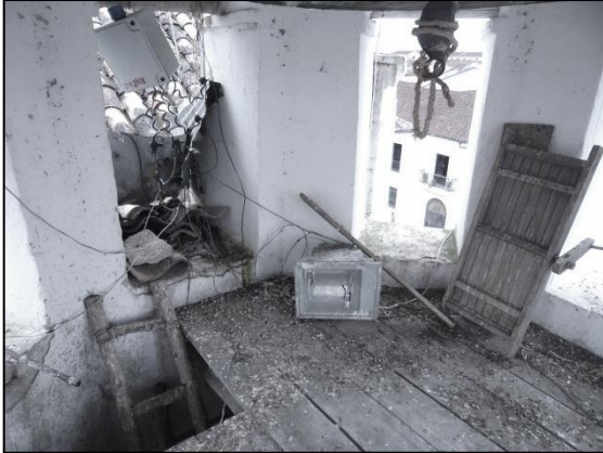
Foto 31. Estado actual del campanario, segundo nivel
