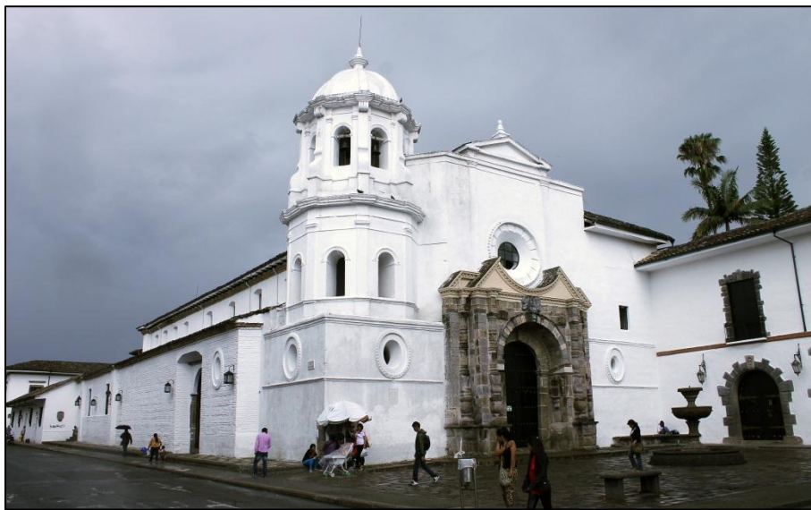
Foto 1. Templo de Santo Domingo. Fachadas norte y occidente. Sobre esta última se observa el pórtico en piedra, fechado en 1741
