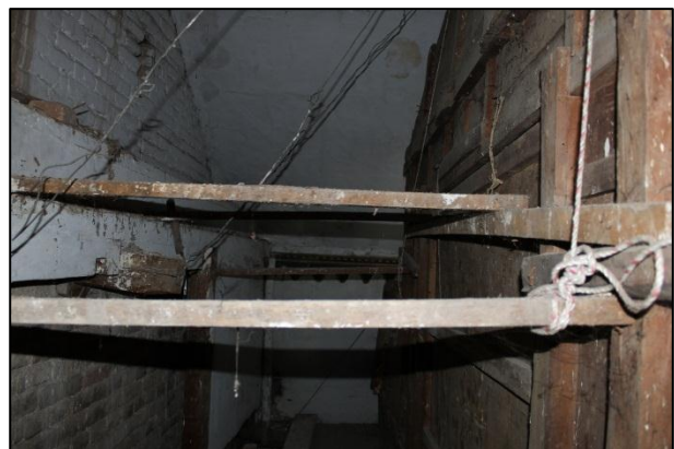
Foto 49. Ensamblajes y sistema de unión del retablo mayor con el muro testero
