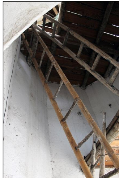
Foto 30. Escaleras de acceso a la parte alta del campanario
