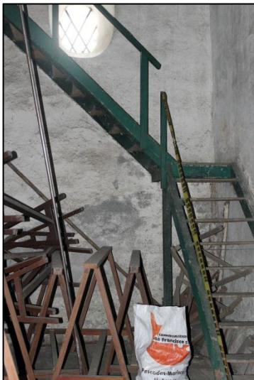
Foto 25. Escaleras de acceso al mezzanine, que lleva al coro y al campanario
