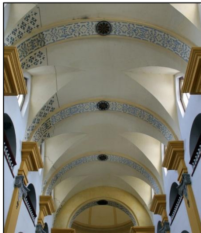
Foto 27. Vista general arcos de la nave central
