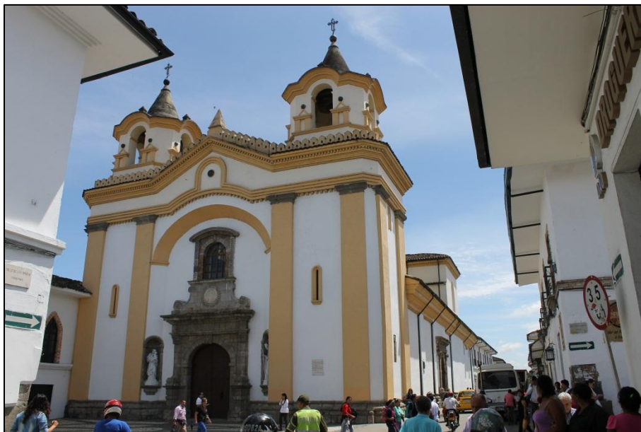
Foto 1. Templo de San José. Fachada principal, costado sur.
