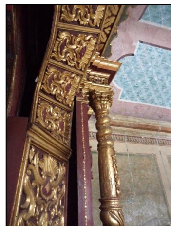
Foto 30. Estado de conservación, columnas retablo mayor
