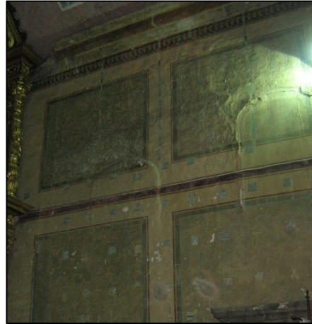
Foto 20. Lámpara sobre costado sur
