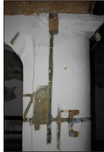
Foto 39. Prospección mural sin contexto en una de las columnas del sotacoro
