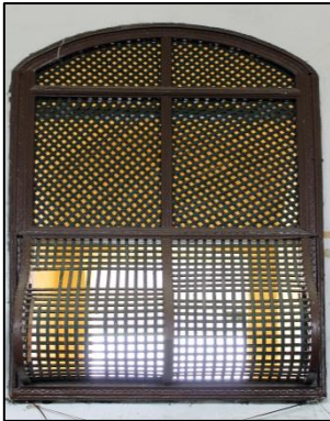
Foto 15. Ventana con celosía sobre el muro sur, segundo piso
