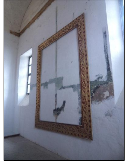
Foto 58. Pintura mural en el camarín, sobre el muro oriente
