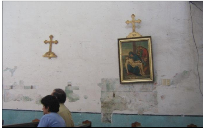
Foto 49. Montaje de litografías en el primer piso, ya se evidenciaba el robo de estos bienes en el año 2008 4
