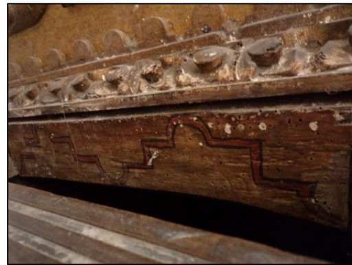
Foto 42. Cavernas causadas por la presencia de deterioro biológico en los retablos
