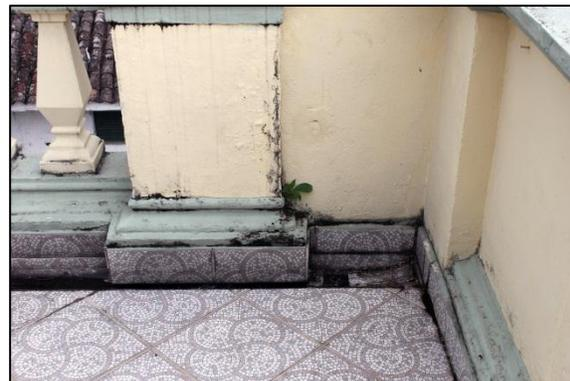
Foto 50. Humedad en terraza, esquina oriente de la fachada norte
