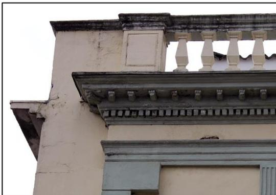
Foto 49. Humedad en terraza, esquina oriente de la fachada norte
