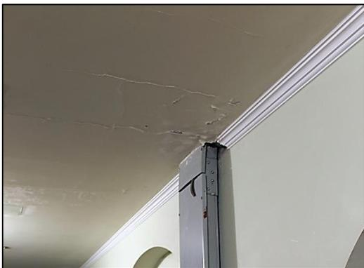
Foto 51. Filtraciones en el techo, humedad en el depósito
