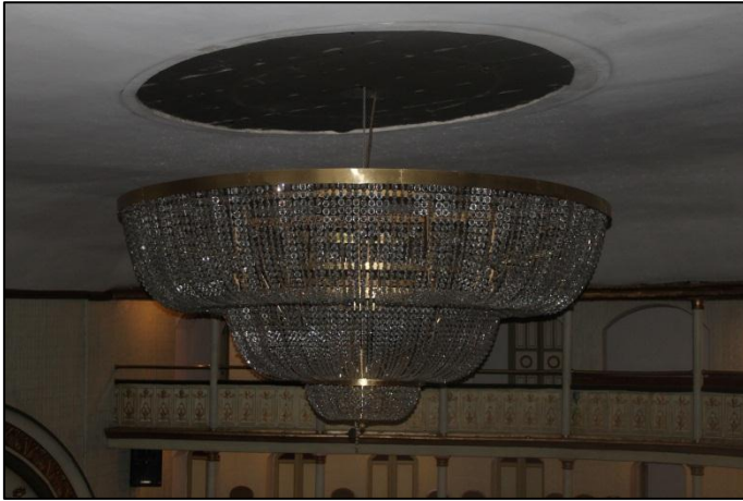
Foto 60. Se observa como la lámpara va descendiendo
