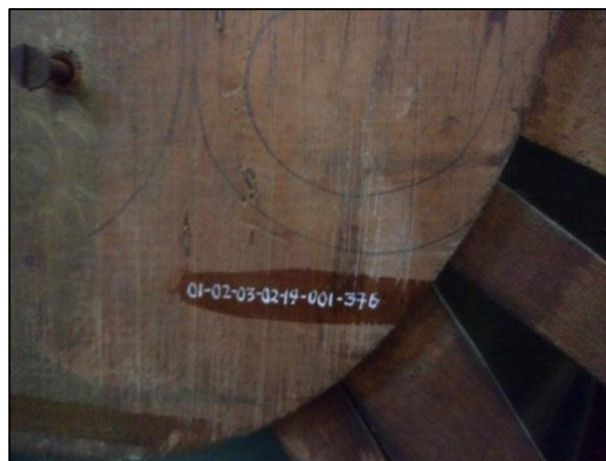
Foto 72. Marcación estructura de rayos Virgen Perpetuo Socorro
