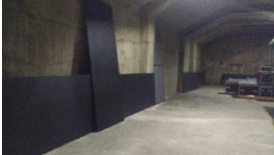
Fotografía 8. Cerramientos metálicos forrados con lona.
