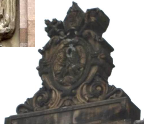
Escudos AE33 y AE32 donde se evidencian excrementos de paloma, eflorescencias, suciedad y ennegrecimientos
