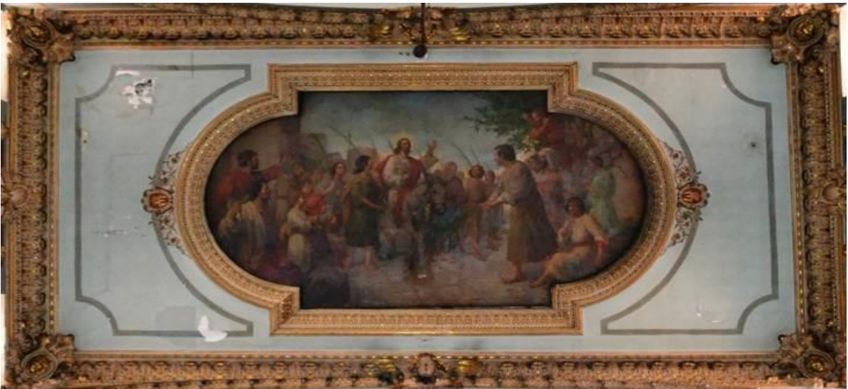
Cielorraso nave central, módulo 6 de oriente- occidente en Septiembre de 2012
