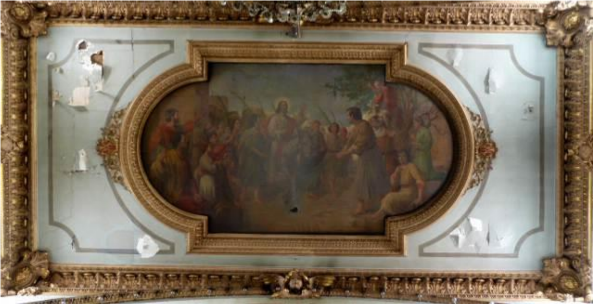
Cielorraso nave central, módulo 6 de oriente- occidente en Febrero de 2012
