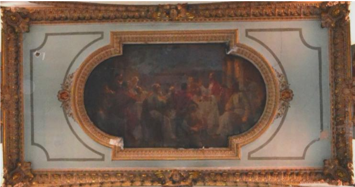
Cielorraso nave central, módulo 7 de oriente- occidente en Septiembre de 2012
