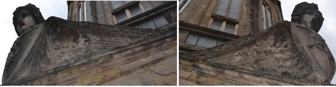
Ángeles AE38 y AE39 donde se evidencian faltantes, eflorescencias, decohesión, suciedad y ennegrecimientos
