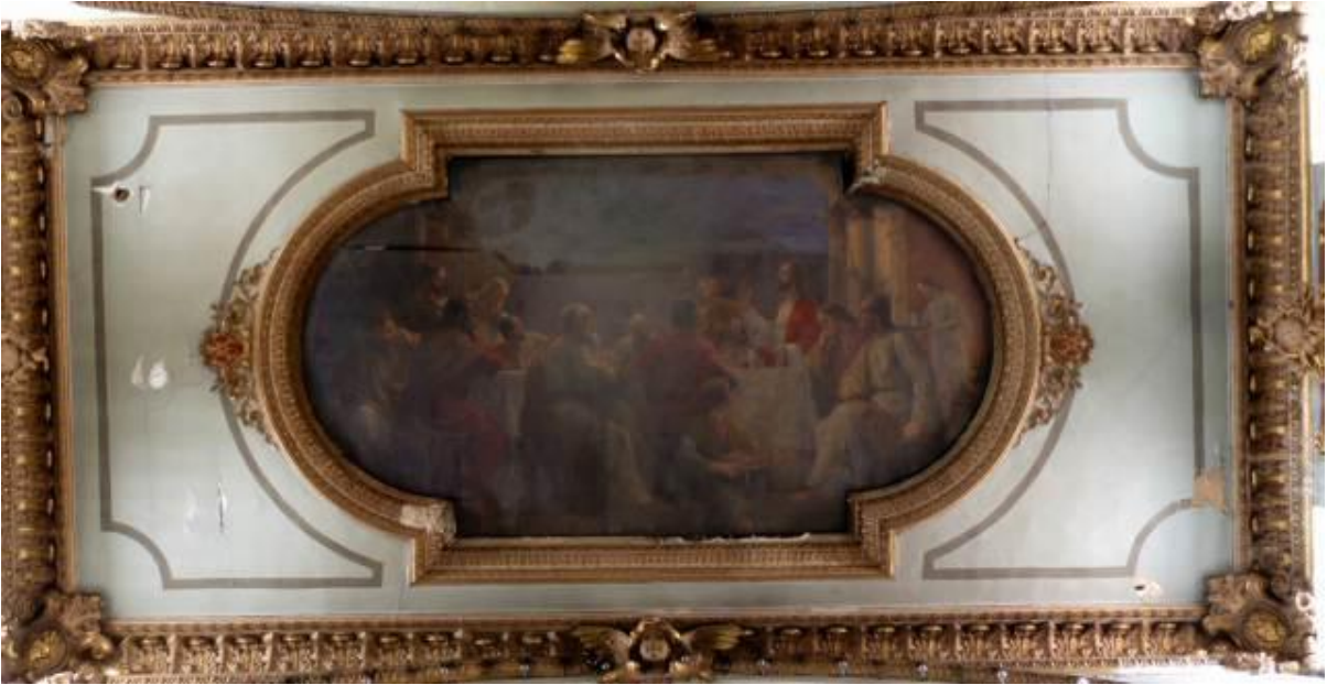
Cielorraso nave central, módulo 7 de oriente- occidente en Febrero de 2013
