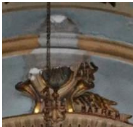
Escudo AE105 con suciedad y faltante de mas del 50%
