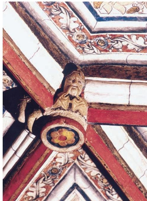
*Figura 8. Detalle del estado de conservación de la película pictórica exfoliada y anclaje de la macolla a la clave de la piedra.*
