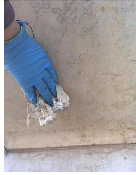
Fotografía 35 Limpieza sobre lajas de marmol con estopa y agua alcohol 1:1
