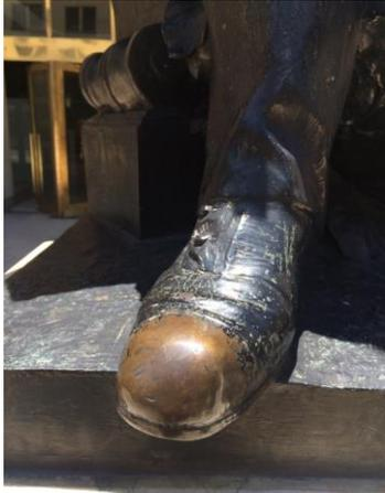
Fotografía 29 Detalle de zapato después de la limpieza.
