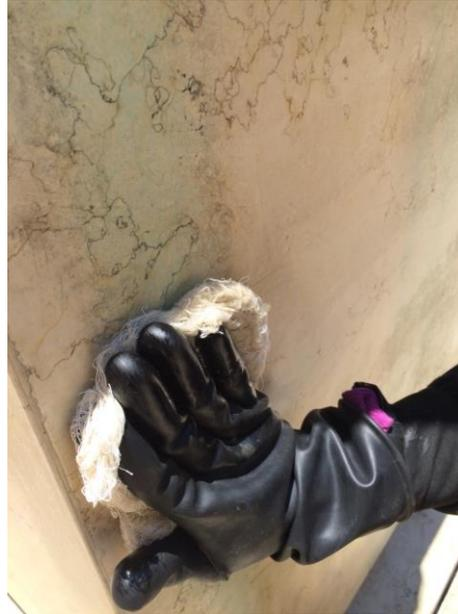
Fotografía 41 Aplicación de capa de protección con estopa.
