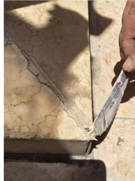
Fotografía 39 Restitución de juntas zona inferior de pedestal.
