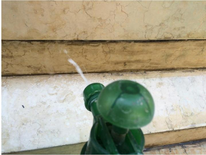
Fotografía 36 Aplicación previa de agua sobre material consistente.
