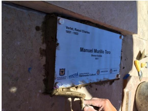
Fotografía 45 Proceso de elaboración de la base de cemento de la placa museográfica
