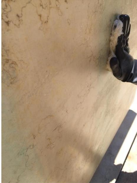
Fotografía 40 Aplicación de capa de protección con estopa.
