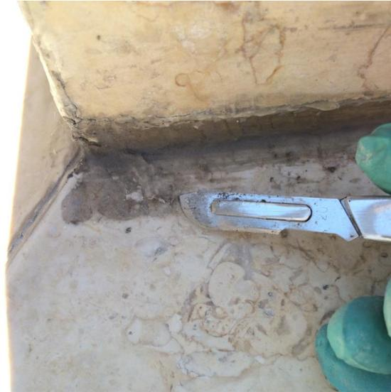
Fotografía 37 Eliminación de restos de adhesivo en bordes y juntas.
